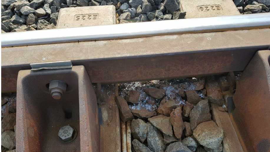
Kuva 61. Vastakiskoprofiilin kulumisen johdosta irronneet metallipartikkelit sekä kiinnityksen modifiointi metallilevyillä vaihteessa V331 elokuussa 2018.
