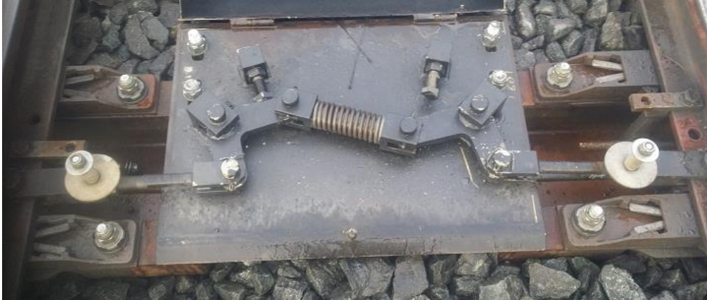
Kuva 4. Vaihteessa V330 käytettävä jousivippe-kääntöavustin.
