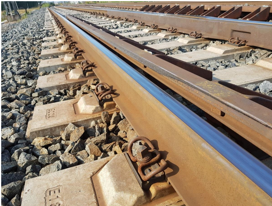
Kuva 60. Vaihteen V331 poikkeavan reitin vastakisko elokuussa 2018.
