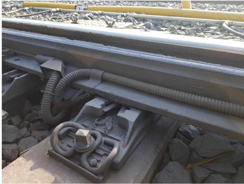
Kuva 42. Vaihteen V331 poikkeavan puolen kielisovituksen kulumistilanne elokuussa 2018.
