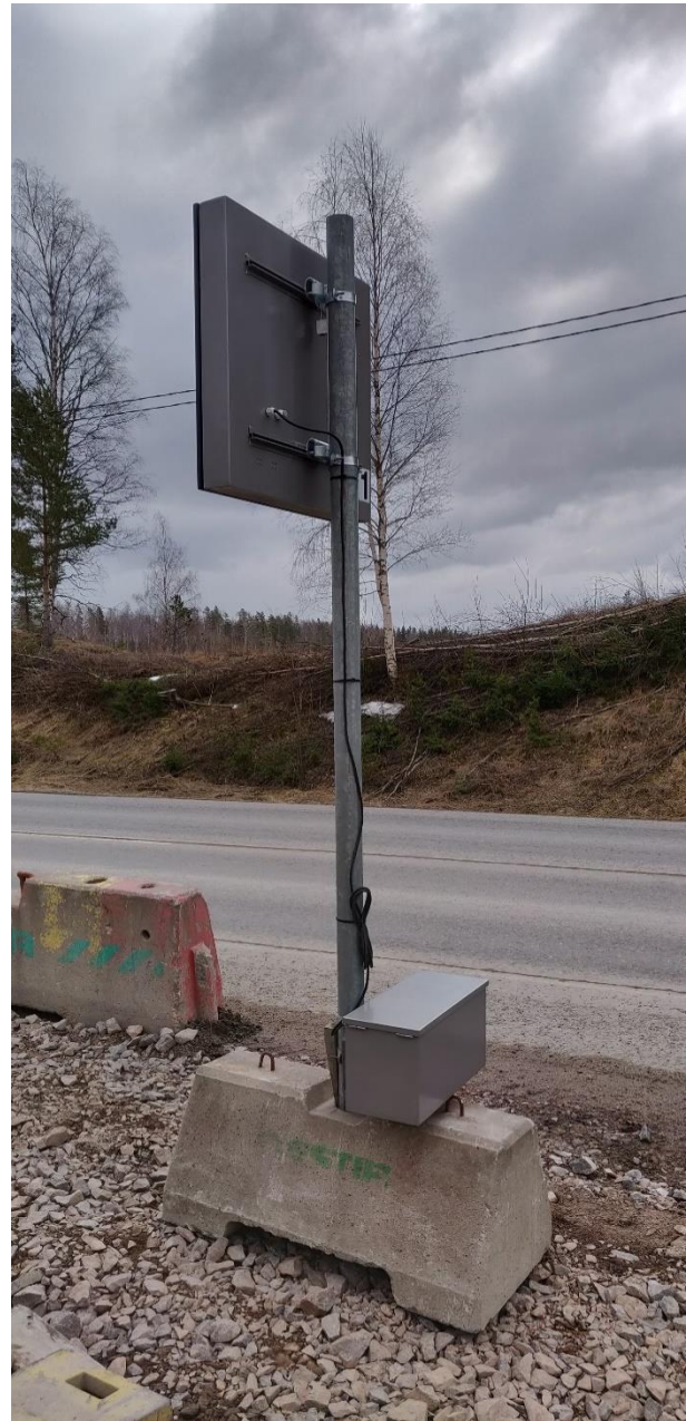
Kuva 2. Laitteen asennus betonijalustalla
