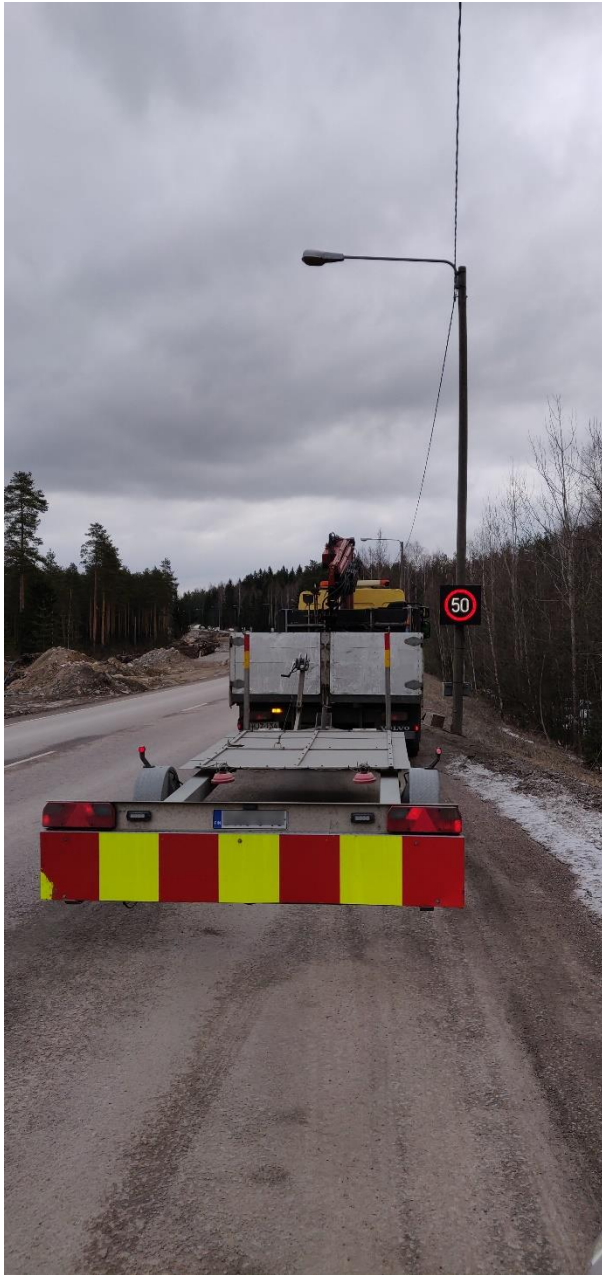
Kuva 1. Laitteen asennus valotolpassa
