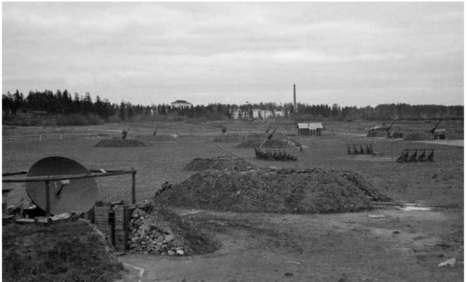
■ 9. Raskaan Ilmatorjuntapatterin tuliasemat Käpylän raviradan maastossa 26.10.1944. Etualalla näkyvät johtopatterin radioluotain ja tulenjohtolaite. Kuvasta voi nähdä patterin tyyppillisen suppean ryhmityksen ja linnoitteiden laadun. Kuva: SA-kuva.
