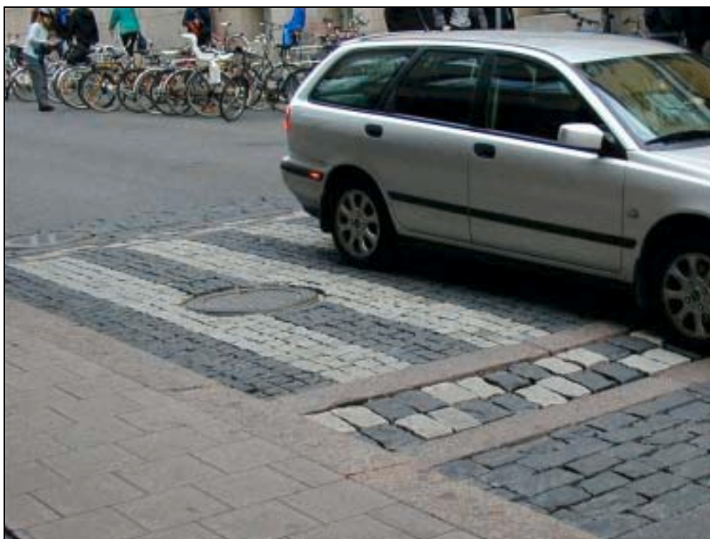
Kuva 2.8 Graniittikivisen ajoradan korotuksen ylläpito edellyttää saumausten hiekoitusta. (Kuva: Asko Kauko / Helsingin kaupunki)
