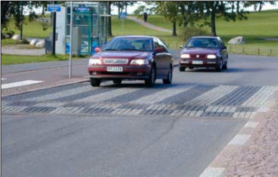
Kuva 2.1 Noppakivistä rakennettu korotettu suojatie. (Kuva: Asko Kauko / Helsingin kaupunki)
