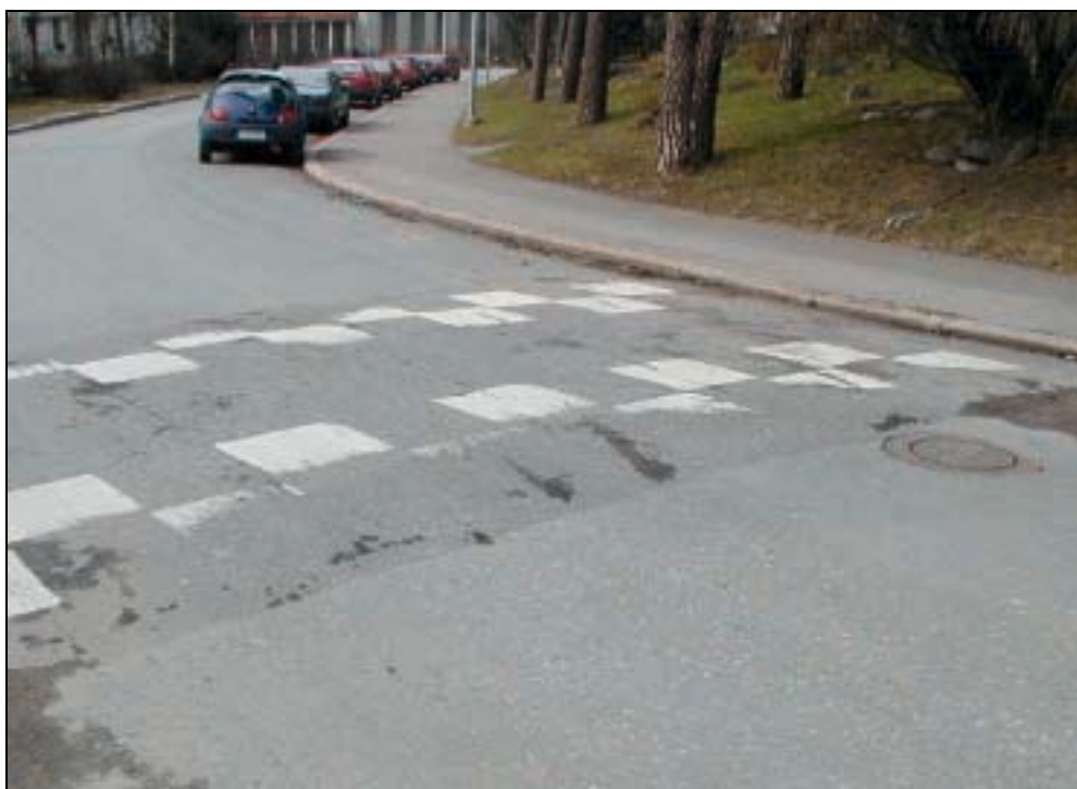
Kuva 2.7 Tiemerkin-nät ovat kuluneet nastarenkaiden ja auruksen vaikutuksesta. (Kuva: Asko Kauko / Helsingin kaupunki)
