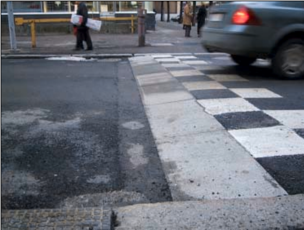
Kuva 4.1 Korotettu suojatie, jonka viisteet on toteutettu uusiomassaelementeillä.
