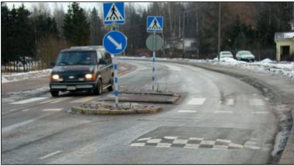
Kuva 2.2 Tyynyhidaste sopii linja-autoliikenteen reitille. Pienemmät autot ajavat korotuksen päältä. Myös linja-autojen nopeus laskee kapean ajolinjan vaikutuksesta. Kuva on Helsingin Sysimiehentieltä. (Kuva: Asko Kauko / Helsingin kaupunki)
