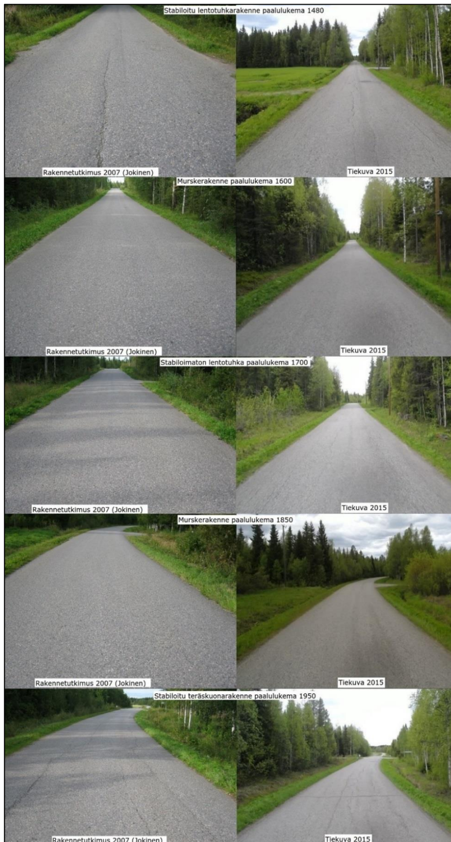
Kuva 70. Pt 19552 Yli-Liakka-Kourilehto. Päällysteen kunto 2007 ja 2015 (Jokinen 2007 ja Tiekuva 2017).
