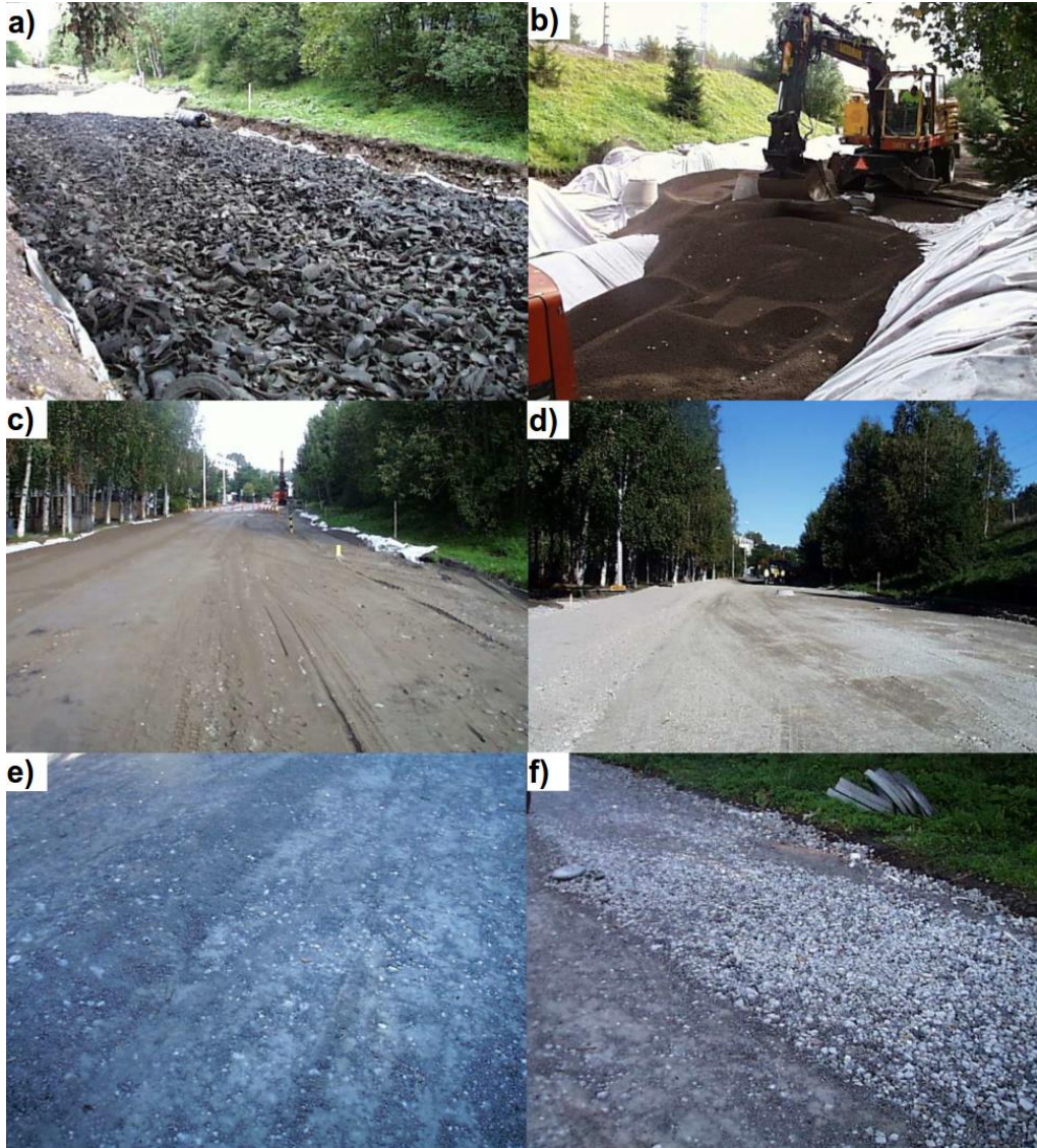
Kuva 103. Parivaljakontie. Rakentamisvaiheen valokuvia. a) levitetty rengasrouhekevennysrakenne, b) kevytsorakevennysmateriaali levitystyö, c) masuunihiekkakerroksen pinta, d) betonimurskekerroksen pinta, e) rakeisuudeltaan laadukkaan, tiivistetyn betonimurskekerroksen pinta ja f) rakeisuudeltaan puutteellisen, tiivistetyn betonimurskekerroksen pinta (Haatainen & Forsman 2001, muokattu).
