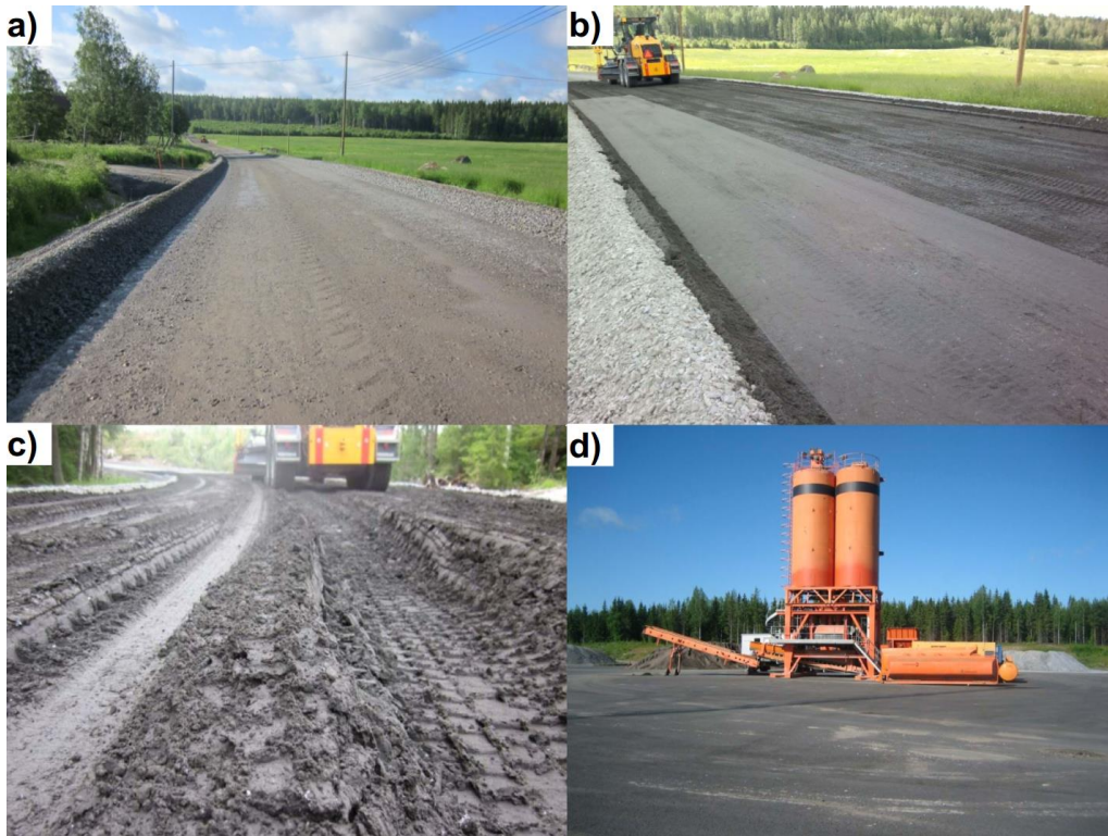
Kuva 105. Yt 13791. Rakentamisvaiheen valokuvia. a) kuitutuhkakerroksen rakennuspohja ja reunatuet, b) kuitutuhkamateriaalin levitystyö ja esitiivistetty pinta, c) liian kostea, häiriintynyt kuitutuhkakerros ja d) kuitutuhkamateriaaliseoksen valmistuksessa käytetty sekoitusasema sekä aumaan varastoidut materiaalit (Mäkinen & Ronkainen 2013, muokattu).
