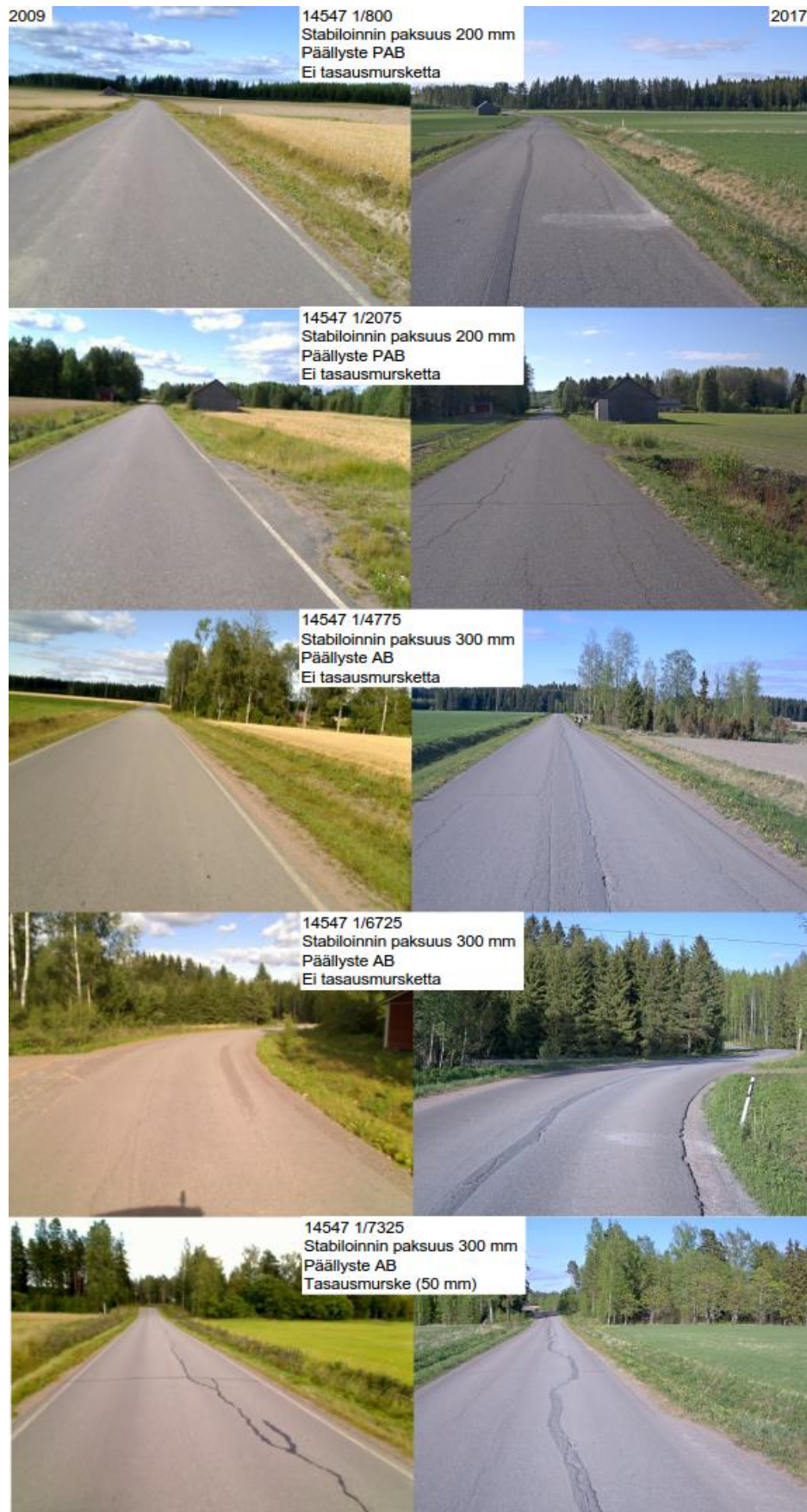
Kuva 76. Yt 14547. Päällysteen kunto 2009 ja 2017 (Tiekuva 2017).
