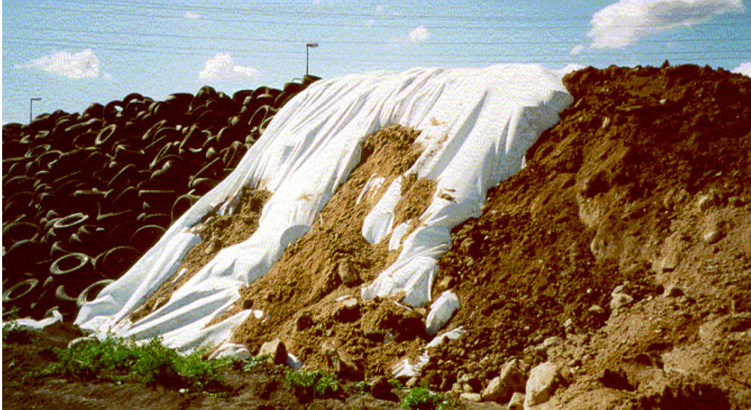
Kuva 53. Vt 7 Porvoo-Koskenkylä. Kierrätettyjä kokonaisia renkaita sisältävän meluvallin rakentamisen eri vaiheita (Palo 2000).
