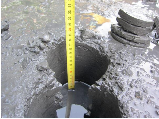
Kuva 34. Yt 14567. Rakennenyhteenotossa halkeillut näyte­kappale paalu­lukema 1400 (kuva: Tero Jokinen 20.8.2013).
