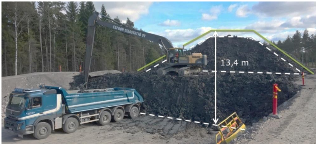
Kuva 60. Kehä I Sepänmäki. Stabiloidusta sedimentistä rakennettu meluvalli. (Forsman et al. 2018)
