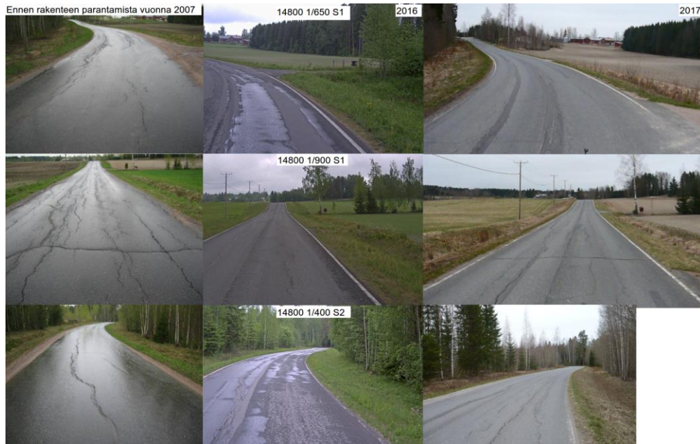
Kuva 83. Yt 14800. Päällysteen kunto ennen rakenteen parantamista (2007) ja rakenteen parantamisen jälkeen 2016 ja 2017 (Hietala et al. 2008, Tiekuva 2017, Harju 2017, muokattu).
