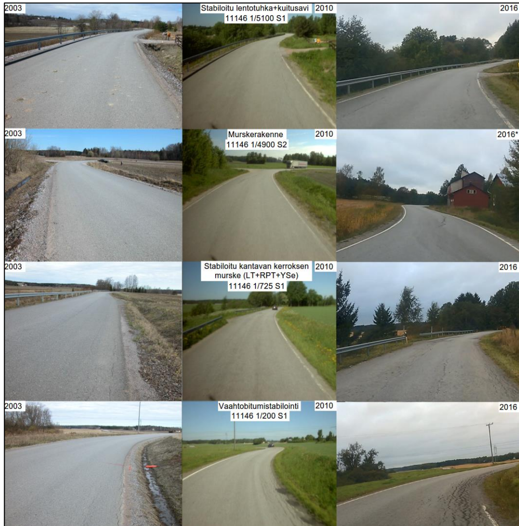
Kuva 72. Yt 11146 Degerby-Tyris. Päälysteen kunto 2003, 2010 ja 2017 (Noussiainen 2003, Tiekuva 2010 ja Forsman 2016). * Kuva suunnassa 2.
