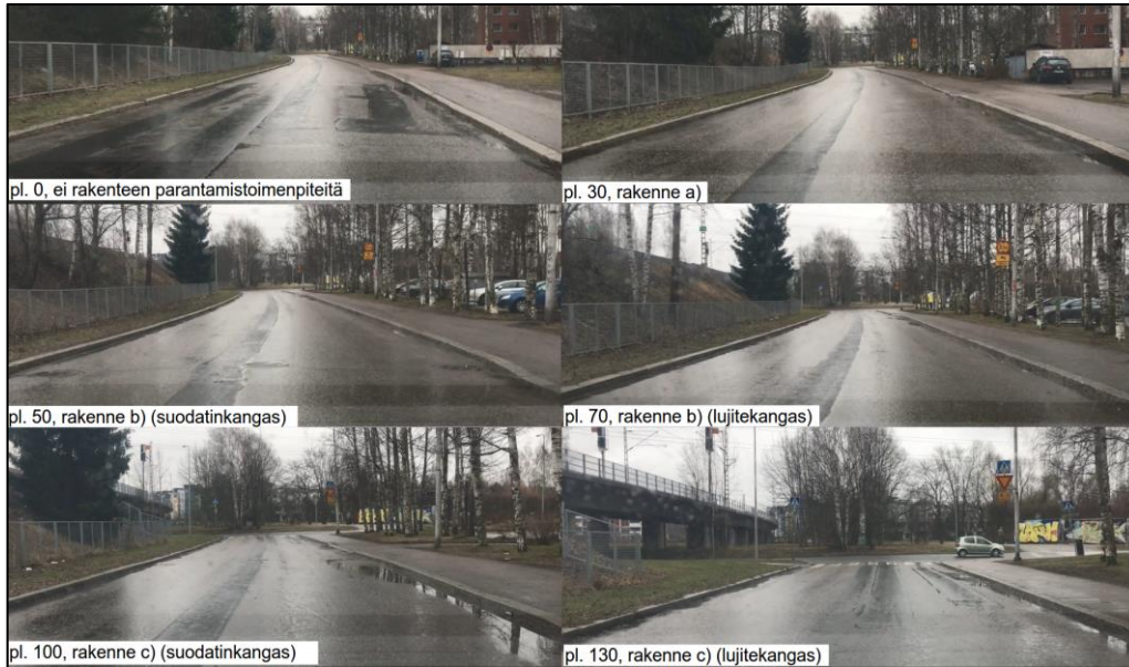
Kuva 77. Parivaljakontie. Päällysteen kunto 2018 (22.4.2018 Ilari Harju).
