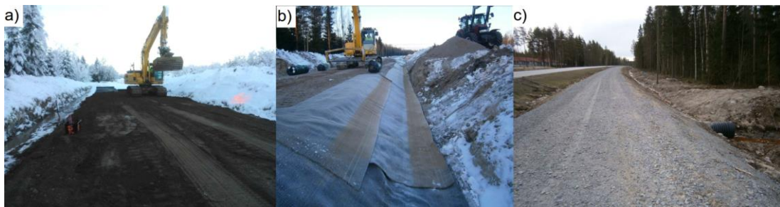
Kuva 106. Mt 741 Lövö-Sandsund. Rakentamisvaiheen valokuvia. a) lentotuhkan tiivistäminen koekentällä, b) bentoniittimaton asentaminen ja c) kevyen liikenteen väylän rakenne ennen päällystämistä (Lummi et al. 2015).
