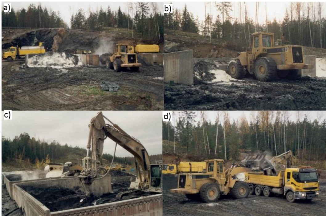
Kuva 9. Yt 11146. Uusiomateriaalien sekoitustyön eri vaiheita. a) sideaineiden punnitseminen ja annostelu sekoituskaukaloon, b) sideaineseoksen esisekoitus kauhakuormaajalla, c) sideaineseoksen sekoitus Maamyrä -sekoitinlaitteella ja d) valmiin sideaineseoksen kuormaaminen kuljetettavaksi rakennuskohteelle (Ahlqvist et al. 2000).
