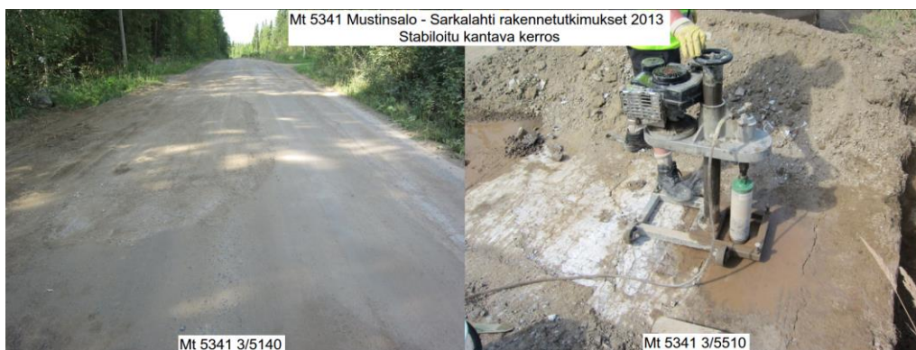
Kuva 82. Mt 5341. Stabiloidun kantavan kerroksen rakennetutkimukset 2013 (Tero Jokinen 7.8.2013).
