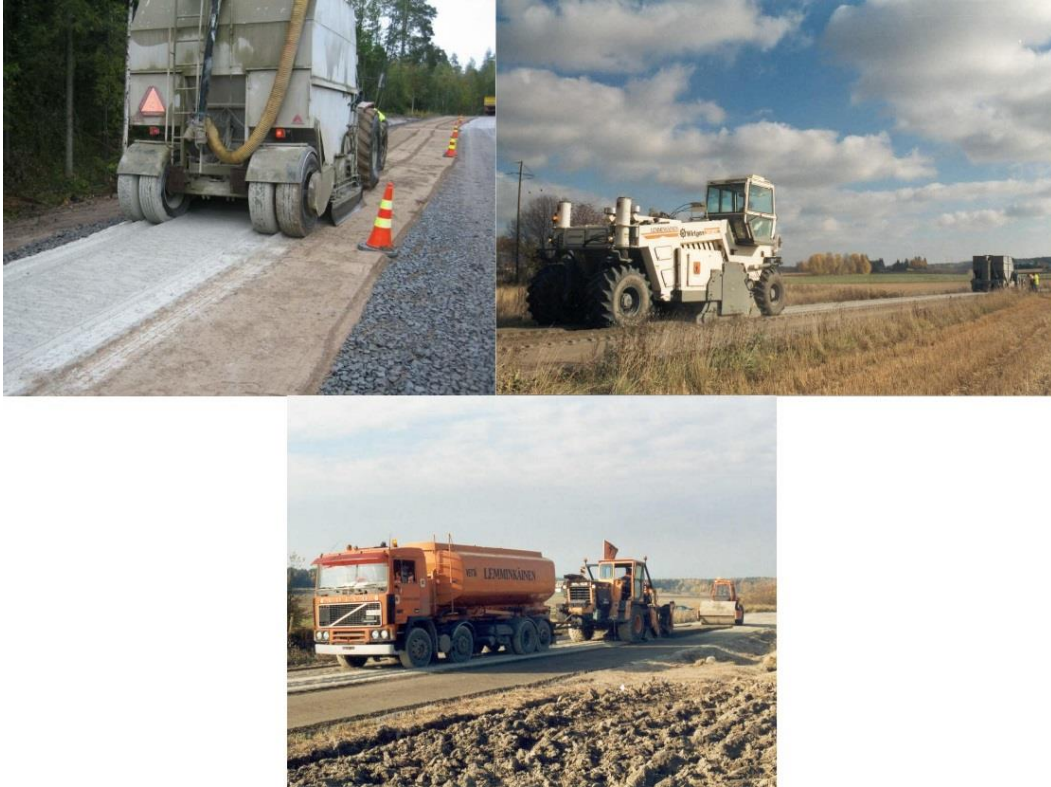
Kuva 104. Yt 11146. Rakentamisvaiheen valokuvia. a) stabiloinnin kuivan sideaineseoksen levityksessä käytetty, traktorin perään kiinnitettävä vaunu (kuva yt 14800 rakennuskohteelta (Jokinen 2007)), b) sideaineseoksen ja olemassa olevan tien rakennekerrosten esisekoitusjyrsintä ja c) esisekoitetun materiaaliseoksen vesipitoisuuden kohottaminen toisen sekoitusjyrsintäkerran yhteydessä ja rakenteen tiivistys (Ahlqvist et al 2000, muokattu).
