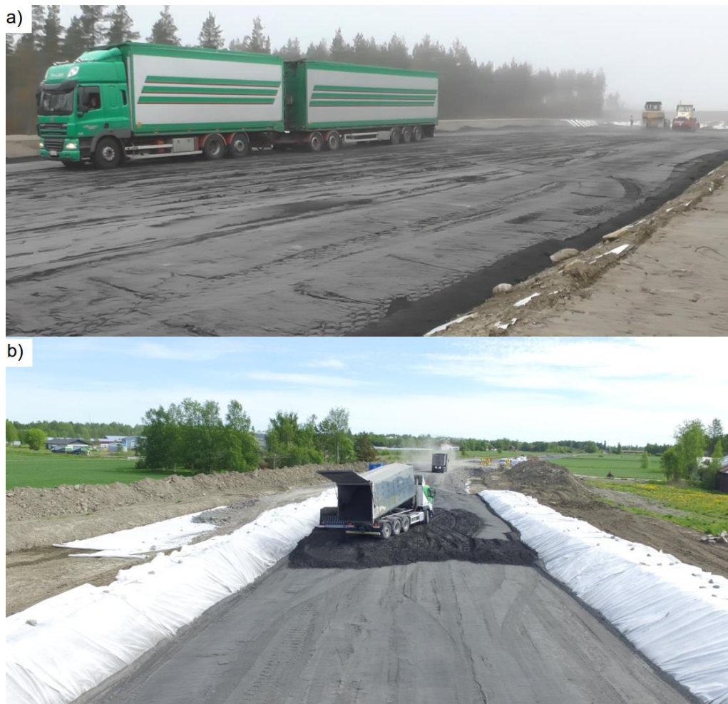
Kuva 57. Sillan tulopenkereen rakentaminen tuhkasta a) Vt19, tuhkapenkereen rakentamista ja siinä käytettyä kalustoa (Mäkinen 2014) ja b) tuhkakuljetuksen purku rakenteilla olevaan pengerrakenteeseen Vt3/Vt8 (Nygård 2017).
