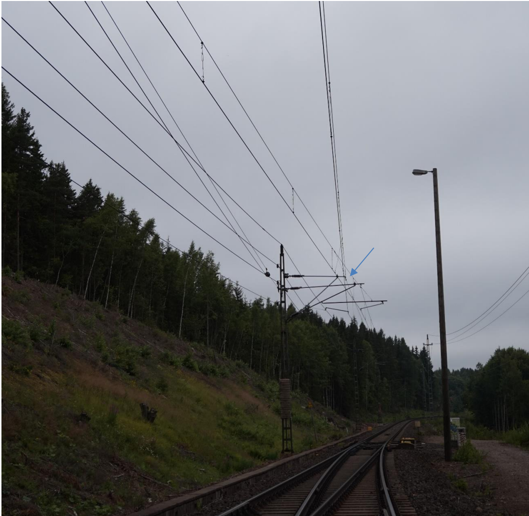
Kuva 11. Kuvassa nähdään hyvin sivuraiteen kohtaamisjätteen yhdistyminen pääraiteeseen sinisen nuolen kärjen kohdalla.
