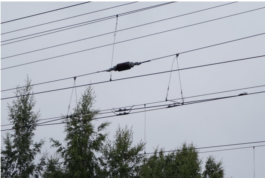
Kuva 9. Ryhmyseristin Lielahden liikennepaikalla.
