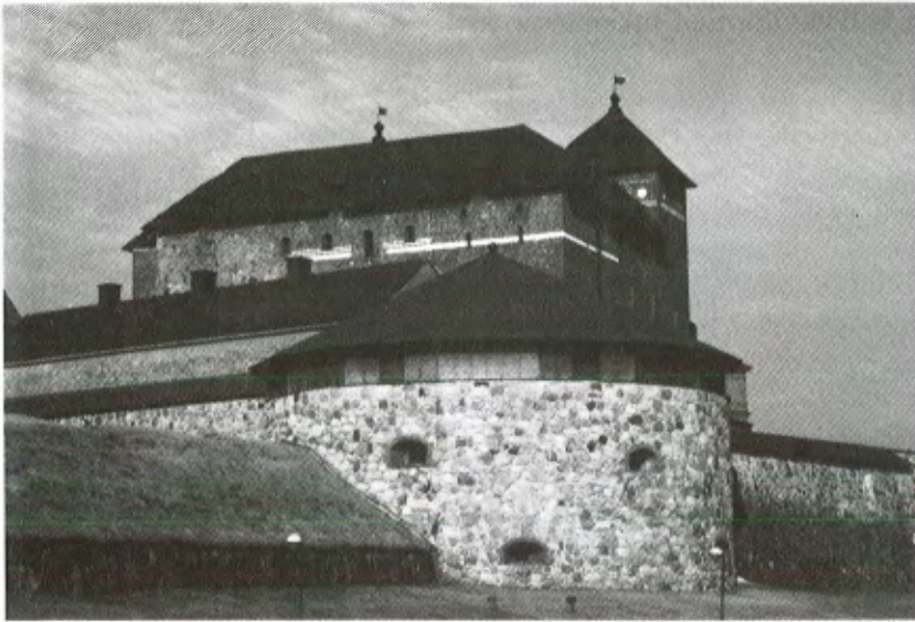
Kuva 12: Vuoden 1559 aikana muurattu itäinen tykkitorni eli rondelli on ainoa Vaasa-ajalta säilynyt rakennelma Hämeen linnassa. Torni muurattiin matalaksi ja ilmeisesti kerroksia oli alunperinkin vain kaksi. Torni oli katettu. Nykyinen katto valmistui linnan entistämistöiden yhteydessä vuonna 1983. Rondellin oikealla puolella on säilynyt osa keskiajalla päälinnaa ympäröineestä kehämuurista. Kuva Päivi Luppi.
