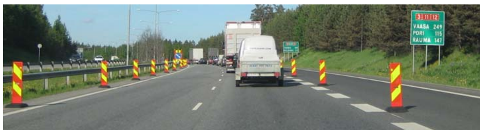
Kuva 5. Esimerkki työmaasta, jossa sulkupylväät on asennettu ohjeiden mukaisesti juovien ollessa kallistuneena ajokaistalle päin.
