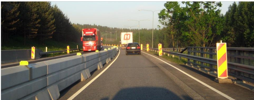
Kuva 24. Testattu työnaikainen betonikaide valtatiellä vastakkaisten ajosuuntien välissä.
