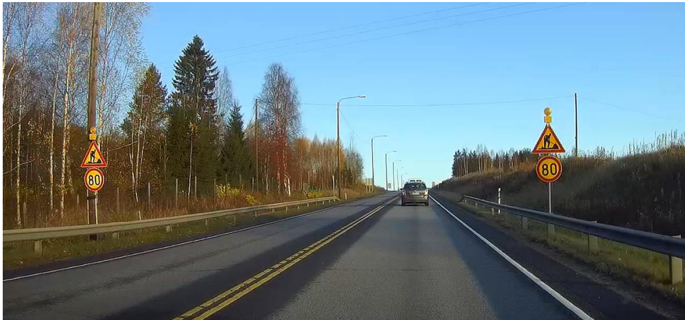
Kuva 22. Varoitusvilkuilla voidaan herättää huomaamaan tärkeät liikennemerkkit.
