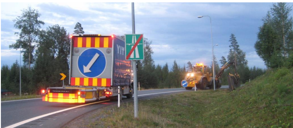
Kuva 19. Törmäysvaimentimella varustettu suoja-ajoneuvo suojaamassa niittokonetta moottoritien rampilla.
