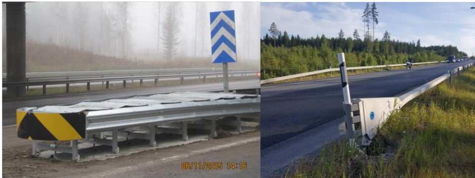
Kuva 26. Kaiteen päähän asennettavia törmäysvaimentimia.
