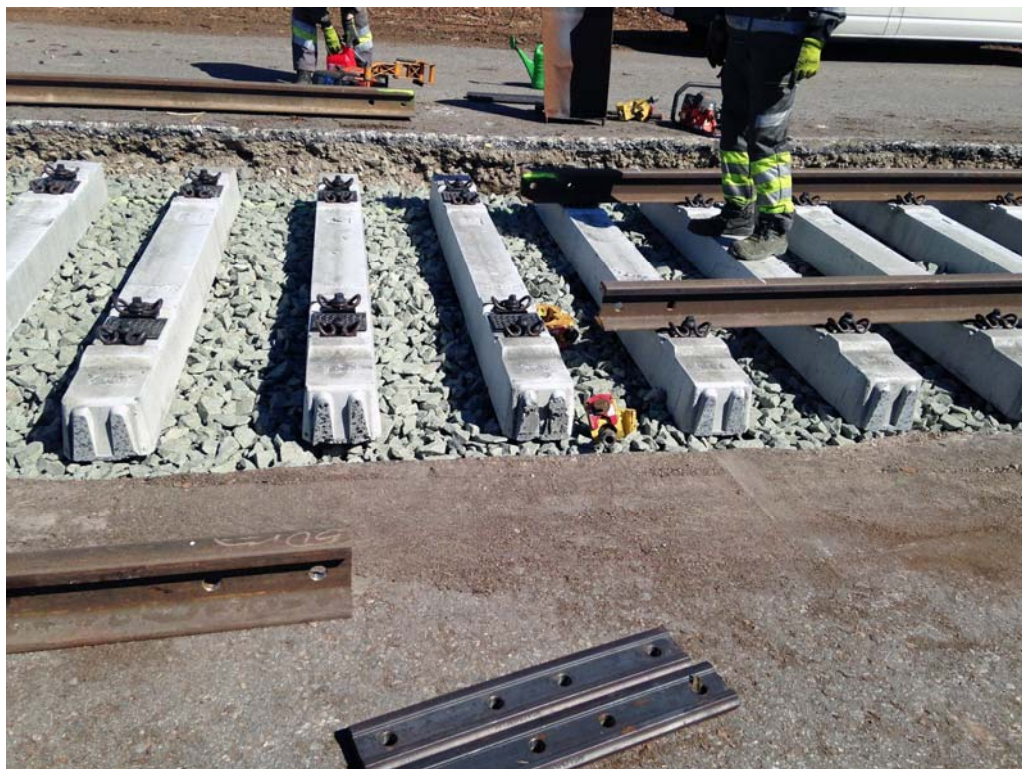
Kuva 3. Rovaniemen raakapuutermiinalin raide 666 parannettiin ratkaisulla, jossa rataan asennettiin viherpölkkyt. Kuva: Kai Kilpi.
