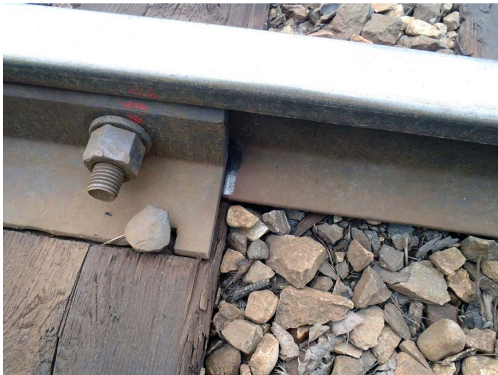
Kuva 82. Huollettu jatkos Ämmänsaaren radalla. Huollossa jatkos avataan ja vaihdetaan komponentteja tarpeellisilta osin. Samalla suoritetaan myös jatkoksen ja kiskon välin rasvaus. Toimenpide vaatii merkittävästi resursseja. Kuva: Janne Sorsa.
