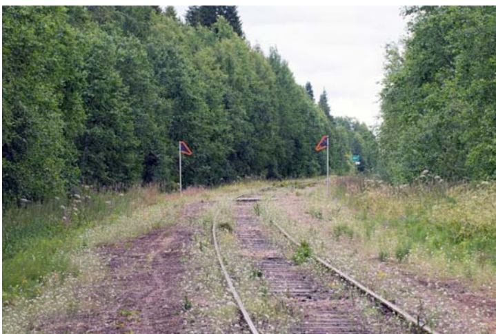
Kuva 29. Pyörämäen tasoisteys Niinisalon radalla 2.8.2017.
