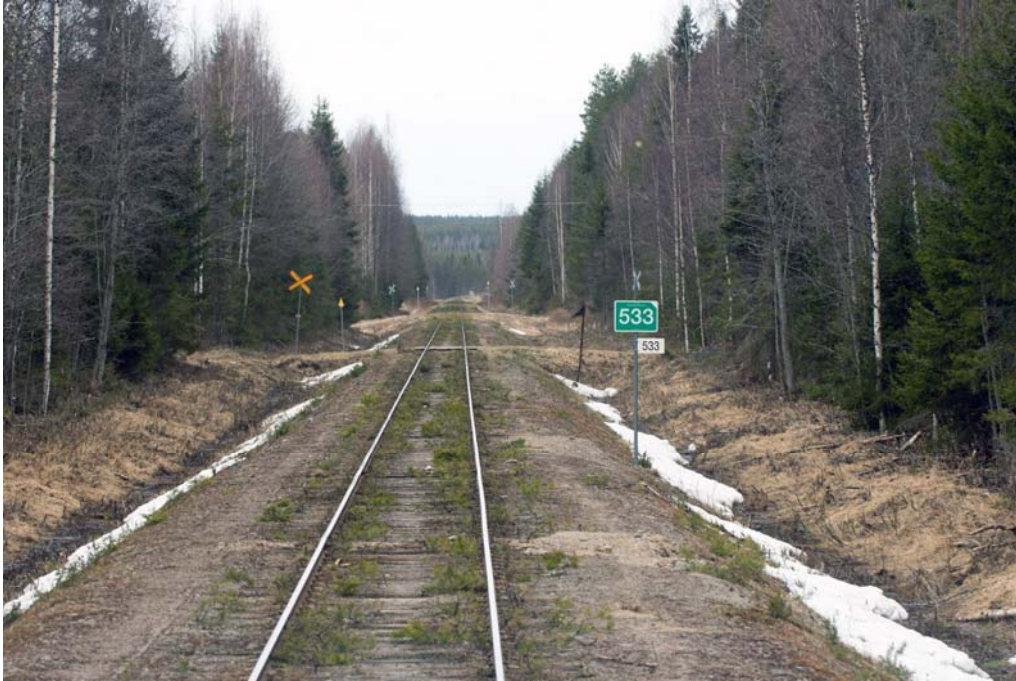
Kuva 48. Soratukikerros, kreosootilla kyllästetyt puupölkkyt ja K30-kiskot Pihtiputaan ja Keitelepuhjan välillä ratakilometrillä 533; 8.5.2017.
