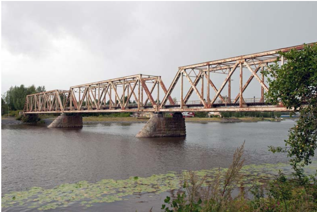
Kuva 96. Kokemäenjoen vuonna 1930 rakennettu ratasilta osuudella Aittaluoto–Ruosniemi.
