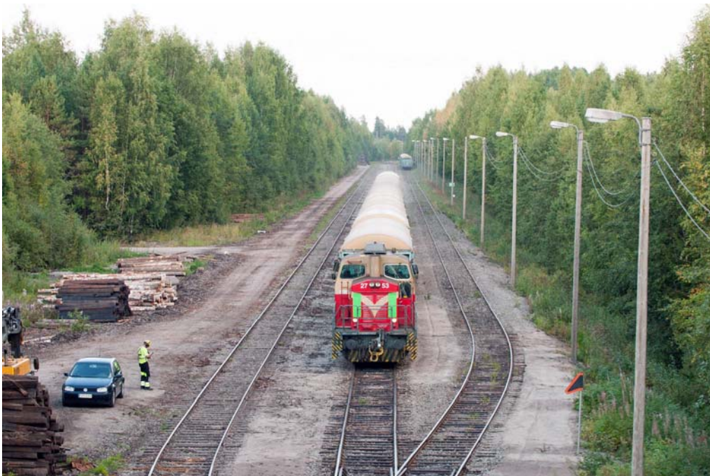
Kuva 55. Tavarajuna lähtövalmiina Ristiinan ratapihalla 25.8.2015.
