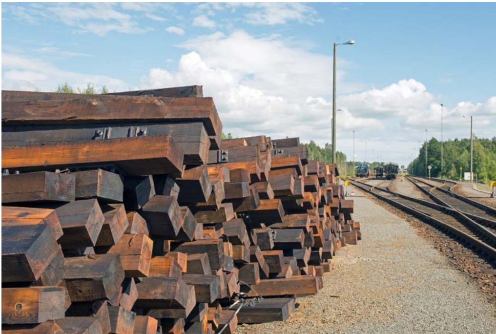
Kuva 2. Uusia kreosottipölkkyjä odottamassa asennusta rataan Mäntyluodossa 11.7.2016.
