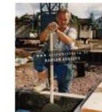
Rakennusmies ahvenanmaalaisella rakennustyömaalla. Rakennusli... Kansan Arkisto
