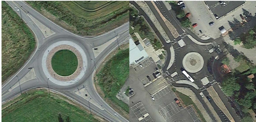
Kuva 3. Maantien kiertoliittymä maaseudulla Hinnerjoella ja taajamassa Lem-päälän Säöksjärvellä. (Google Maps 2017)
