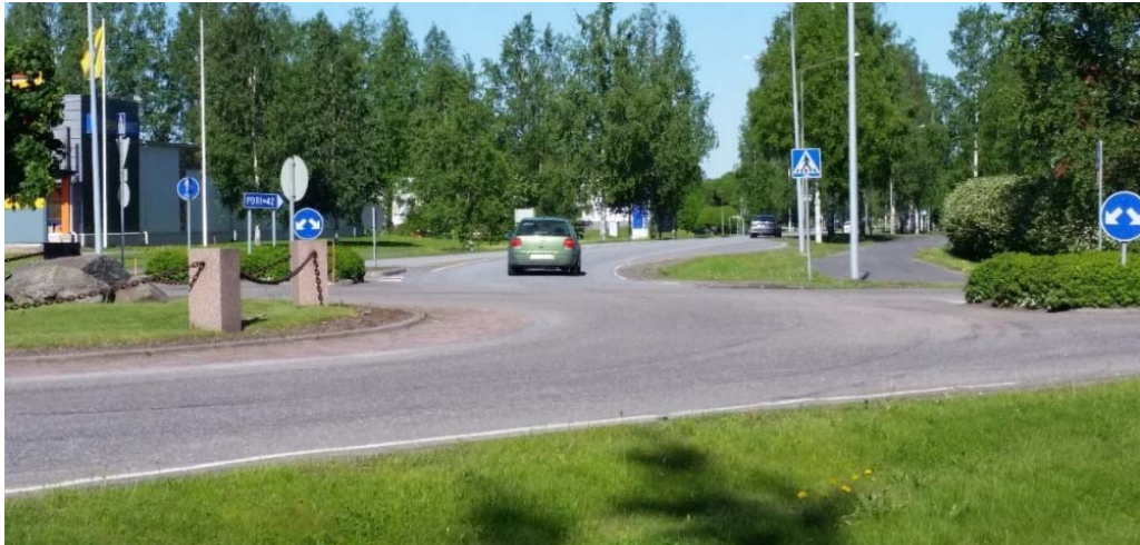
Kuva 20. Kauvatsantien kiertoliittymän poistumissuunta lännen suuntaan.
