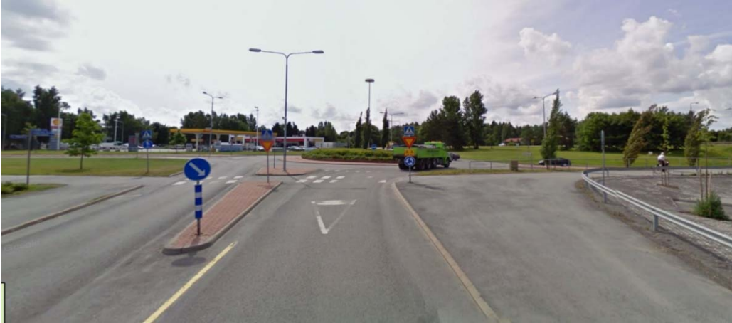
Kuva 29. Näkymä Tikkulan kiertoliittymään pohjoiselta liittymähaaralta. Kuvassa oikealla yhdistetty pyörätie ja jalkakäytävä on tarpeettoman leveä liittymää lähestyessä (Google Maps 2017).
