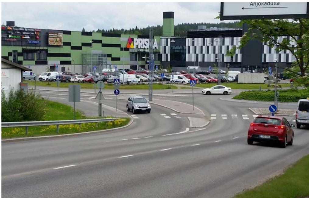
Kuva 9. Merasimen kiertoliittymän oikealle kääntymiskaista poistumissuunnalta kuvattuna.
