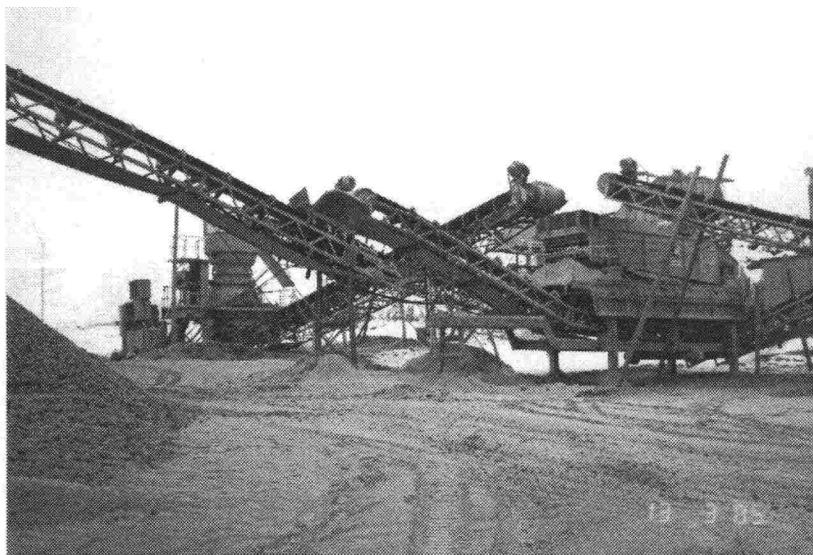
Hieman uudempi murskauslaitos 1980-luvulta. Kuva: J. Rapila
