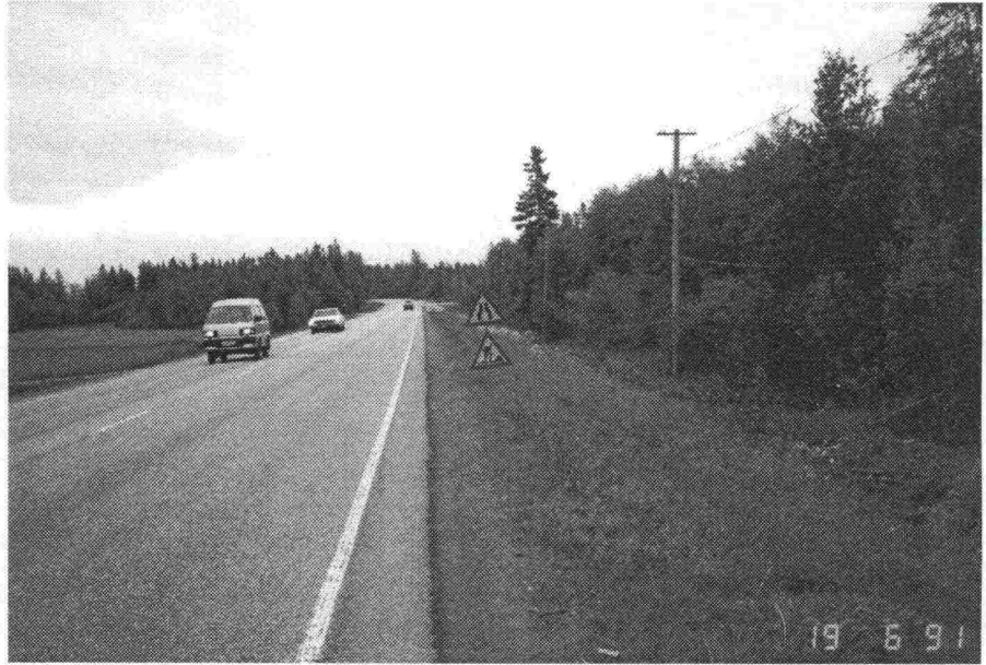
Tämä liikennemerkki ei vastaa työmaatilannetta, ja se on vain unohtunut ja painunut "häpeissään" miltein maan povaan. Kuva: J. Rapila
