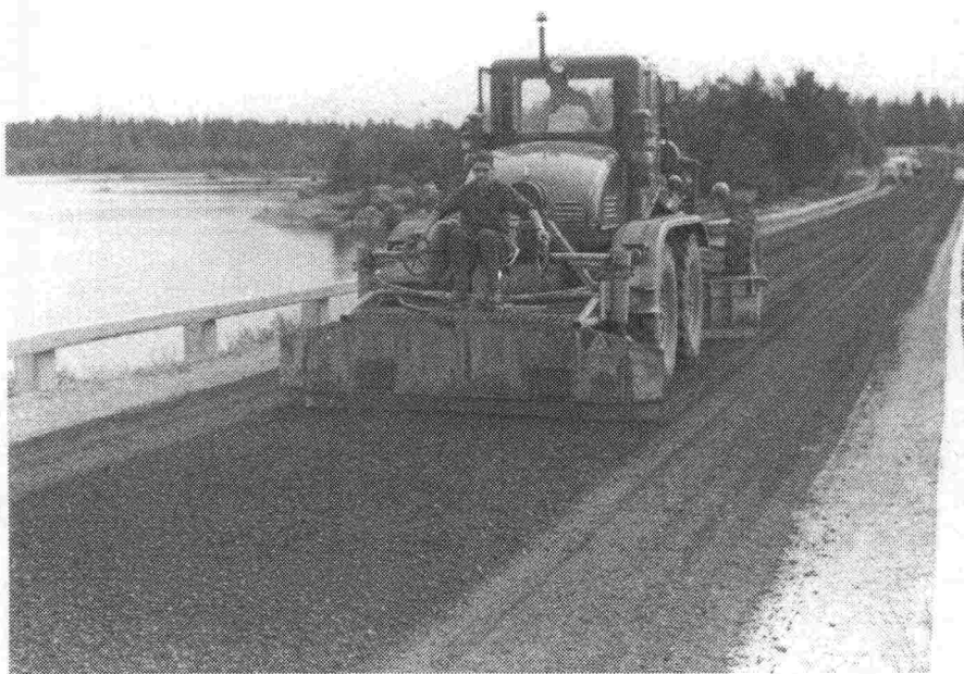
”Hoito jatkuu” Tasoittajahöylä perämiehineen (Heikki Vehkaoja). Kuva: Ilpo Tarkkanen
