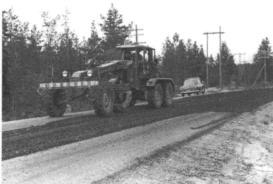
Öljysorapäällysteen "hoitoa" v. 1962. Öljysoran rikkomista lautasrepijällä. Kuva: Ilpo Tarkkanen
