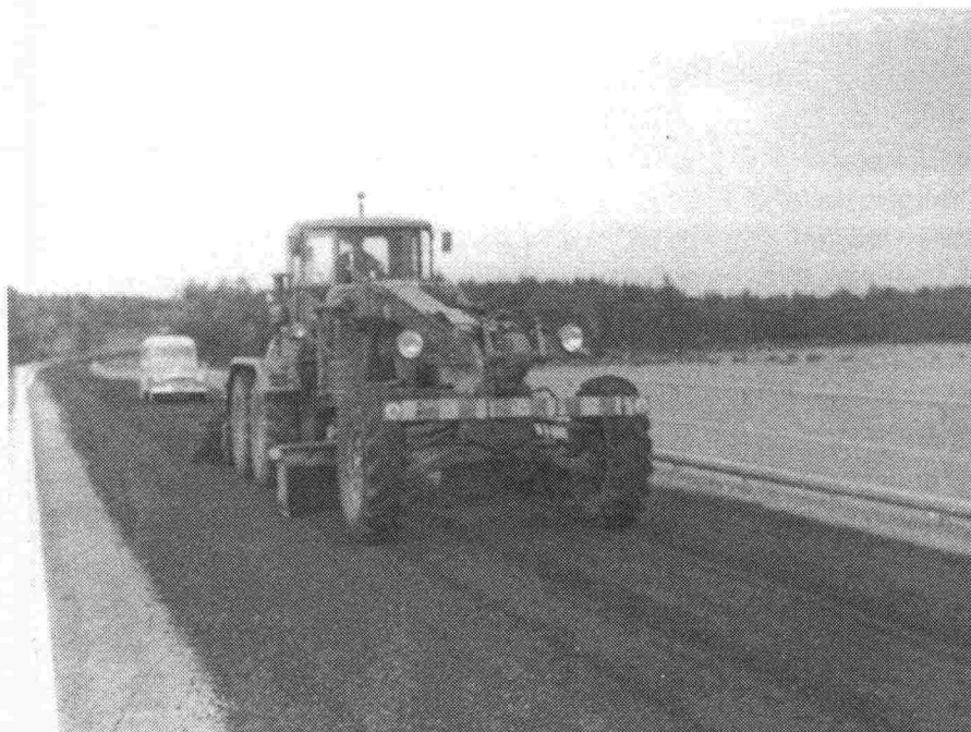
”Hoito jatkuu”. Karhitun tiepinnan tasaamista tasoittajalla. Kuva: Ilpo Tarkkanen
