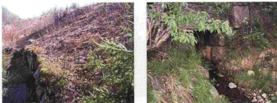
Kuva L6.1 Pienen rummun pää maastossa. Rumpu on vielä kohtuudella havaittavissa, sillä luiskassa ja ojassa ei ole kovin paljon kasvillisuutta.
