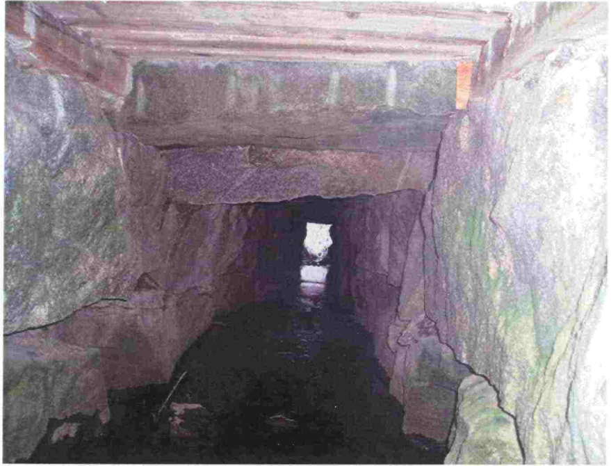
Kuva L6.3 Tyypillinen kivrumpu, jota on todennäköisesti jatkettu kuvaussuuntaan päin edelleen kiviseinillä, mutta kansilaatta muuttuu kivrakenteisesta teräsbetonirakenteiseksi.
