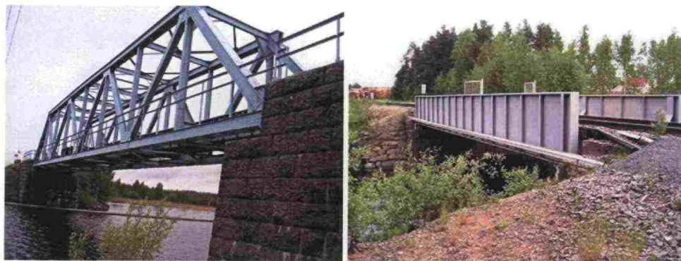
Kuva L6.12 Pääosa teräsrakenteisista rautatiesilloista on vanhoja teräsristikko- ja teräspalkkisilloja.
