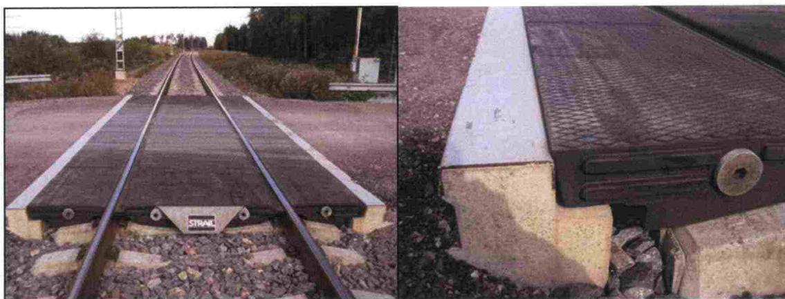
Kuva 46. Strailin kumitasoristeys siirtymäpaikoilla varustettuna.
