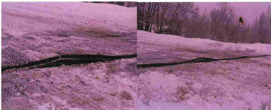
Kuva 10. Routiminen nostaa kantta jopa ATUn sisään.
