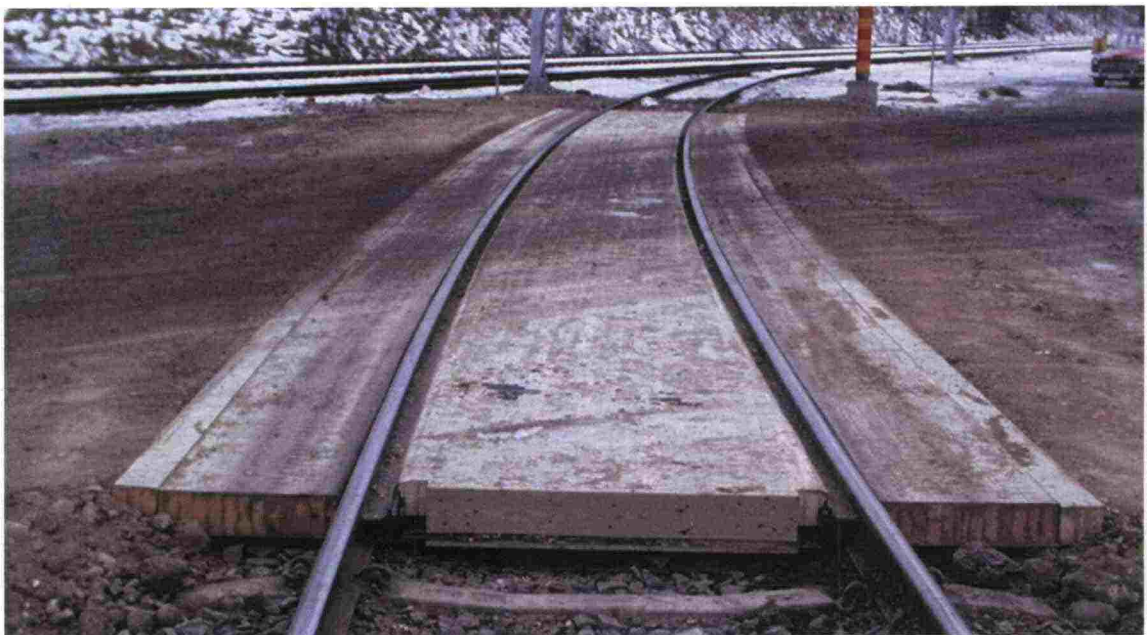
Kuva 25. Suomen pisin yhtenäinen liimapuutasoristeyskansi, jonka pituus oli 22,2 m. Kansi kesti erittäin raskasta liikennettä n. 2 vuotta.
