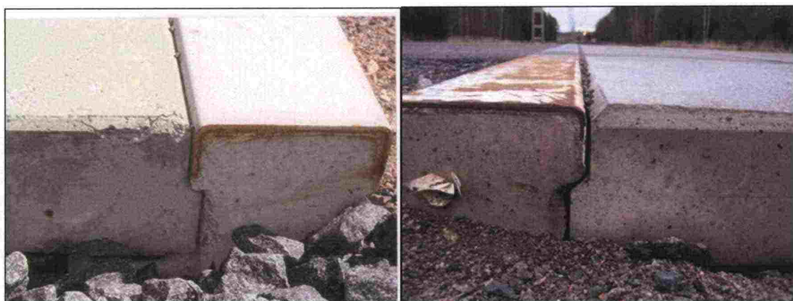
Kuva 51. Vasemmalla 90 asteen ponttireuna ja oikealla 45 asteen ponttireuna, joka on asennuksessa parempi kuin 90 asteen reuna.
