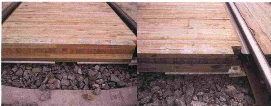
Kuva 33. Keskikannen 3-kerrosrakenne.
