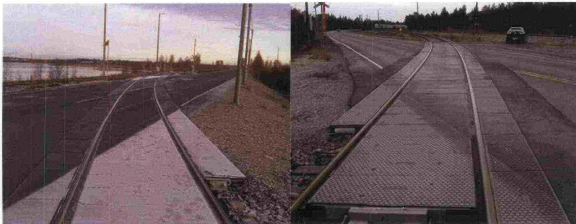
Kuva 47. Liikenne tiivistää saumoja (vasen kuva) ja liikenne löystyttää saumoja (oikea kuva).
