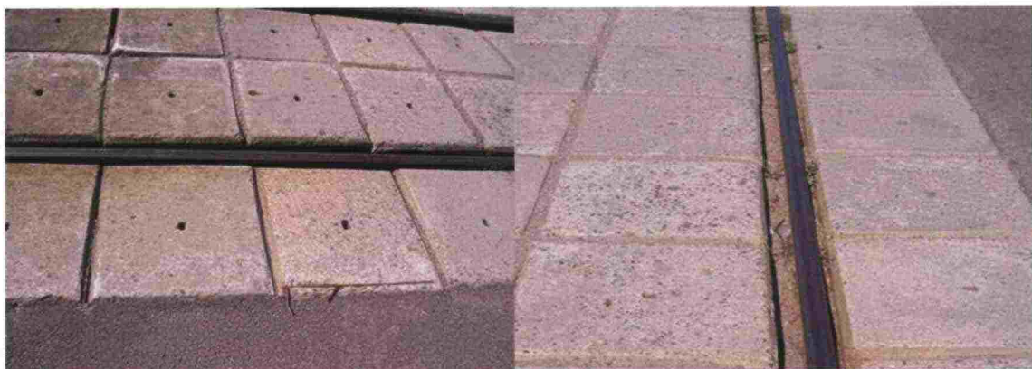
Kuva 48. Vanhanmalliset käytöstä poistuvat betonielementit.
