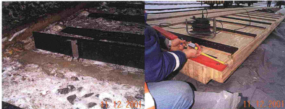
Kuva 22. Kumikorotuspalat vasemmalla edellyttävät lähes aina vanerikorotuksen kanteen.
