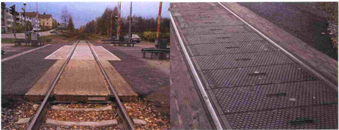
Kuva 62. Yhdistelmä rakenne puu-betoni-raiteen suunnassa ja puu-kumi-puu-tien suunnassa.
