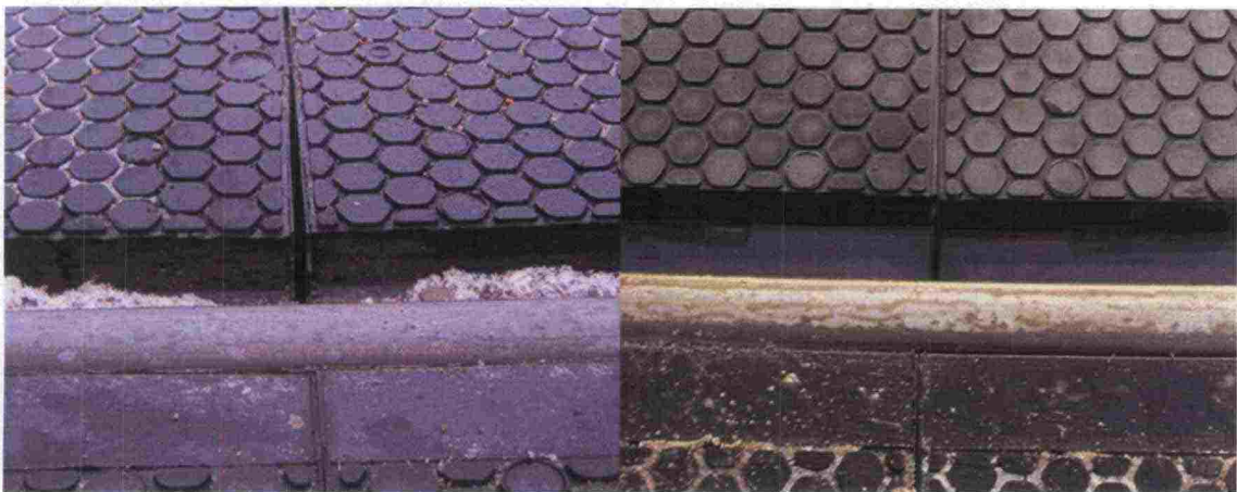
Kuva 45. Keskielementin aukeaminen kiskon vierestä on ratkaistu ja korjattu.
