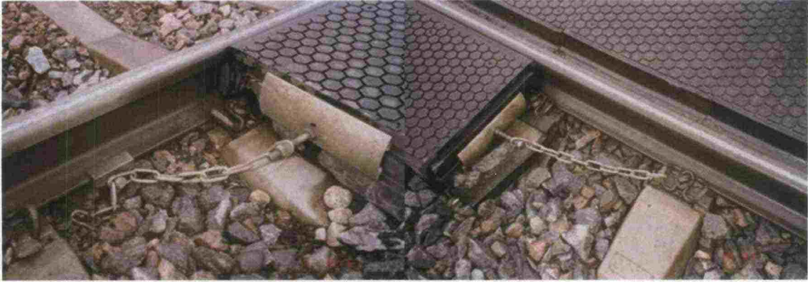
Kuva 7. Nämä ankkurointitavat eivät ole luvallisia.
