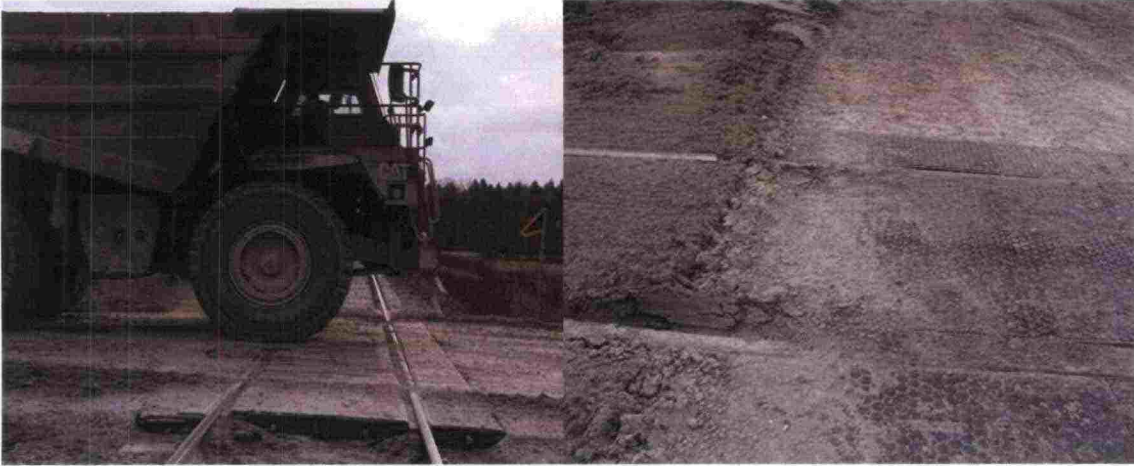
Kuva 52. Kumikansi korvattiin yhtenäisellä betonikannella. Dumpperien akselipaino kuormassa on n. 50...60 tonnia.
