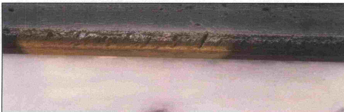
Kuva 63. Moottorikelkan ohjausraudan jättämiä jälkiä kiskossa.
