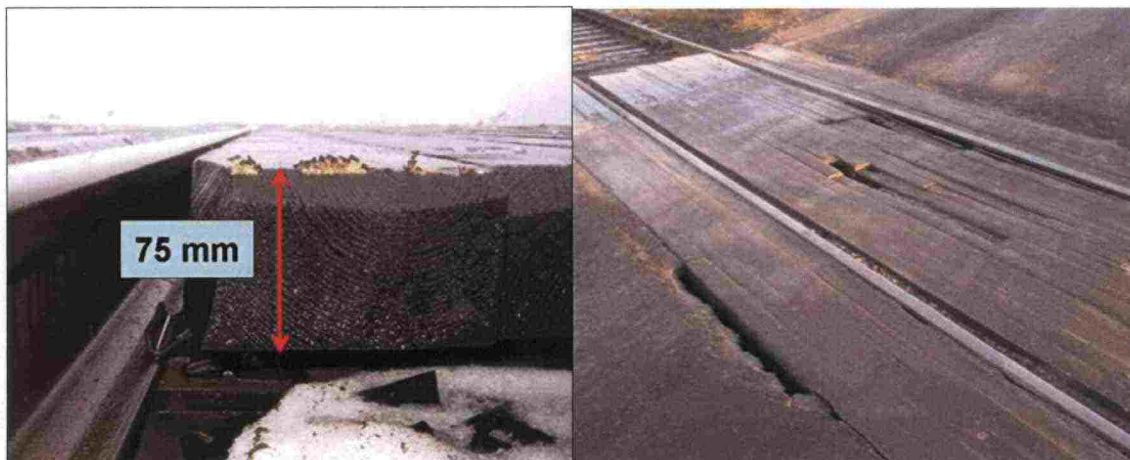
Kuva 9. Kansilankkujen vahvuutena lappeelleen naulatuissa ei riitä 63...75 mm:n vahvuus.
