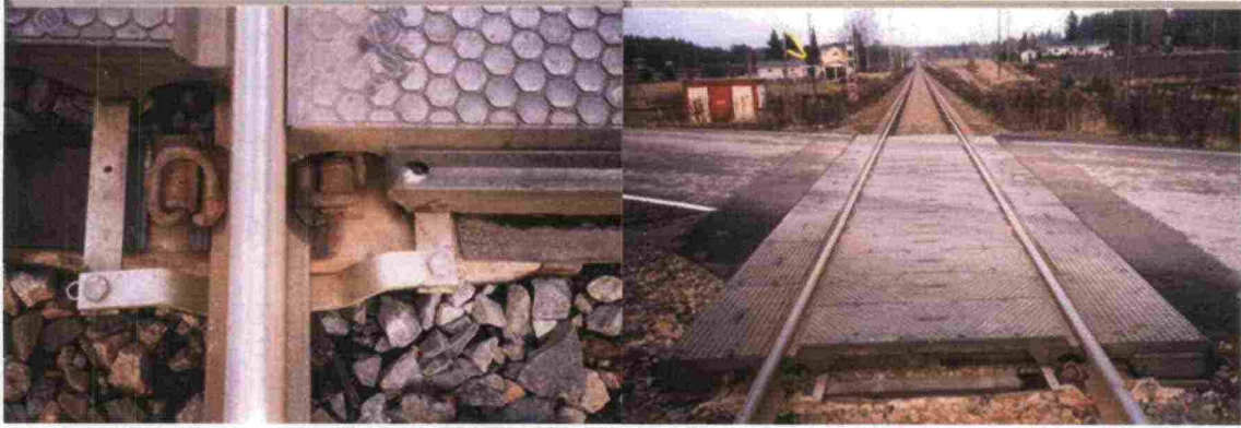
Kuva 44. Teknikum Oy:n tasoristeyksen ankkurointi.
