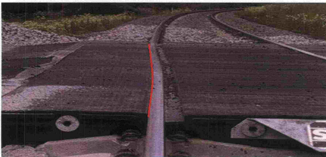
Kuva 17. Raiteen sivusiirtymä voi olla oleellinen ja vaarallinen.
