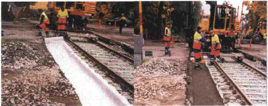
Kuva 39. Siirtymäpalkin pohjan teko.
