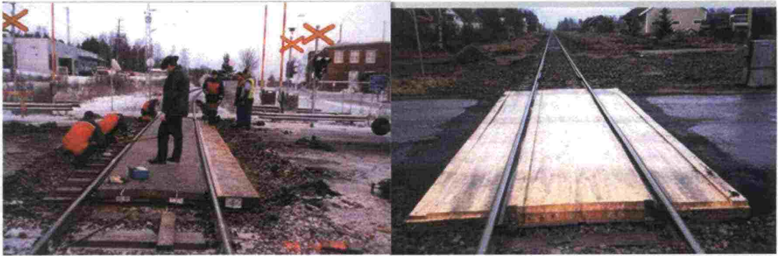
Kuva 24. Ensimmäinen liimapuukansi vasemmalla ja ensimmäinen yhtenäinen käsin naulattu kansi oikealla.
