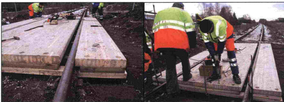
Kuva 28. Ankkurointi yhtenäisellä kiskojen alta menevällä ankkuripuulla 63x125 mm soveltuu myös normaalikansiin.
