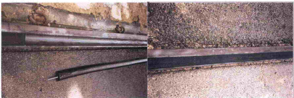
Kuva 77. Liimaus (vasen kuva) ja turvallinen liikenteelle (oikea kuva).
