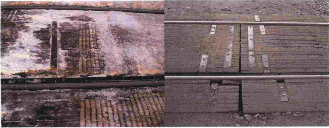
Kuva 81. Auran terät ovat olleet alhaalla vasemmalla. Miten olisi käynyt vastaavassa tapauksessa oikealla?
