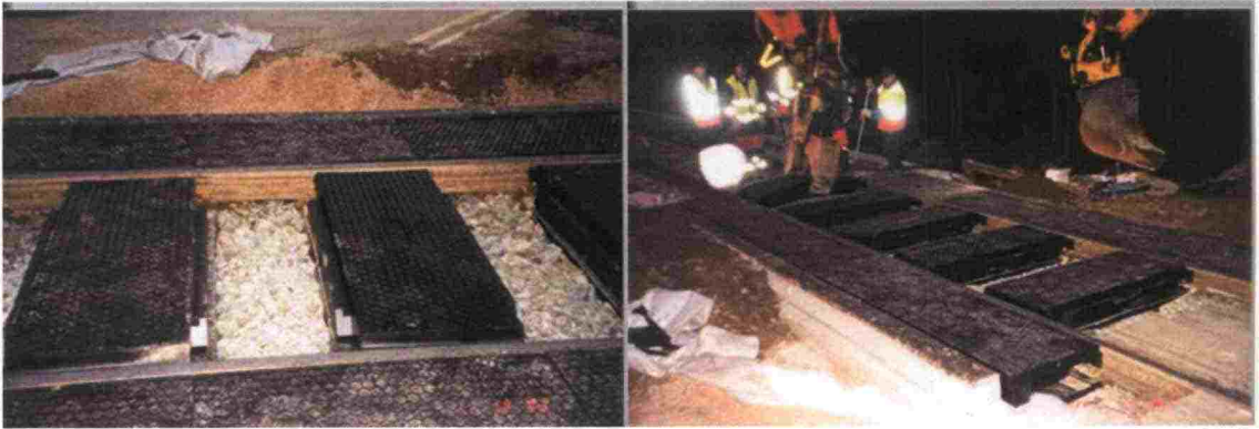
Kuva 42. Pystyponttisuus mahdollistaa elementin poistamisen toisten elementtien välistä.
