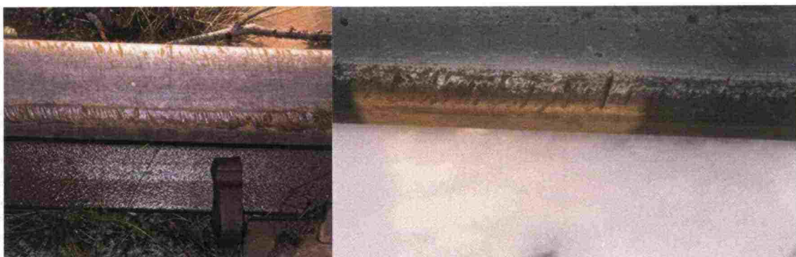
Kuva 18. Moottorikelkan jättämiä jälkiä kiskossa.
