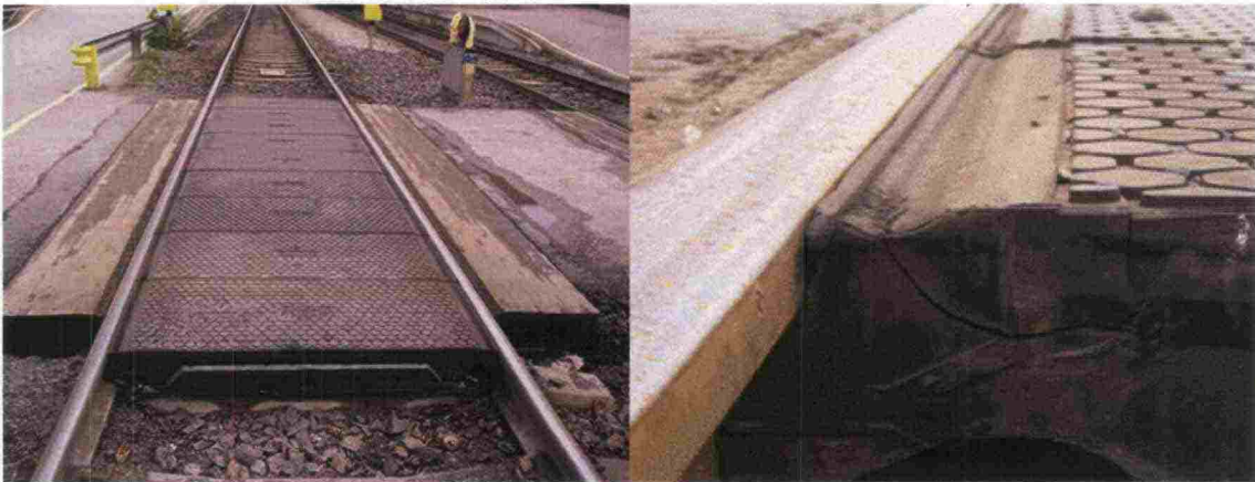
Kuva 73. Kuminen laippauraton massiivirakenne.
