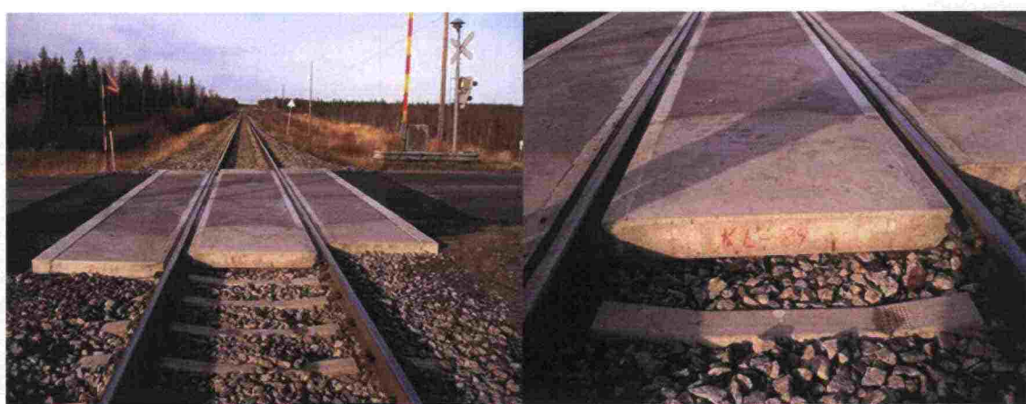
Kuva 56. Valtion rataverkolla käyttöön hyväksytty uusi betonitasoristeysmalli.
