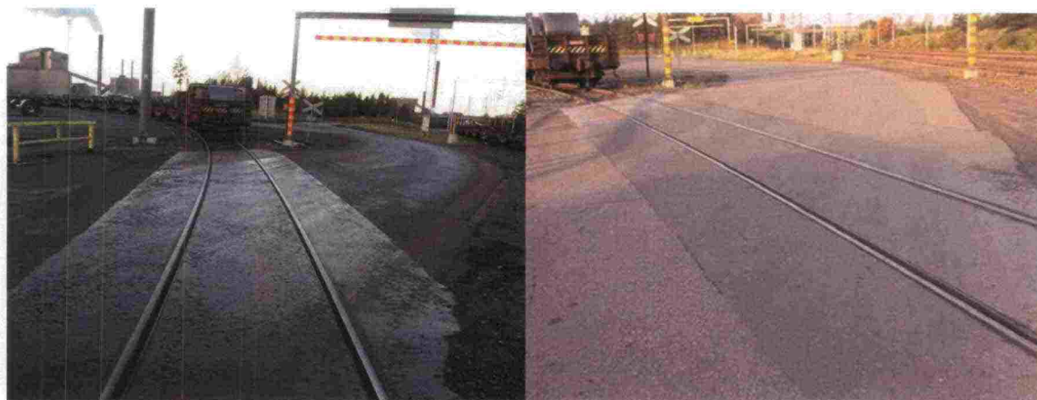
Kuva 59. Rautaruukin Raahen tasoristeys ja oikealla sama tasoristeys 4 vuoden kuluttua.
