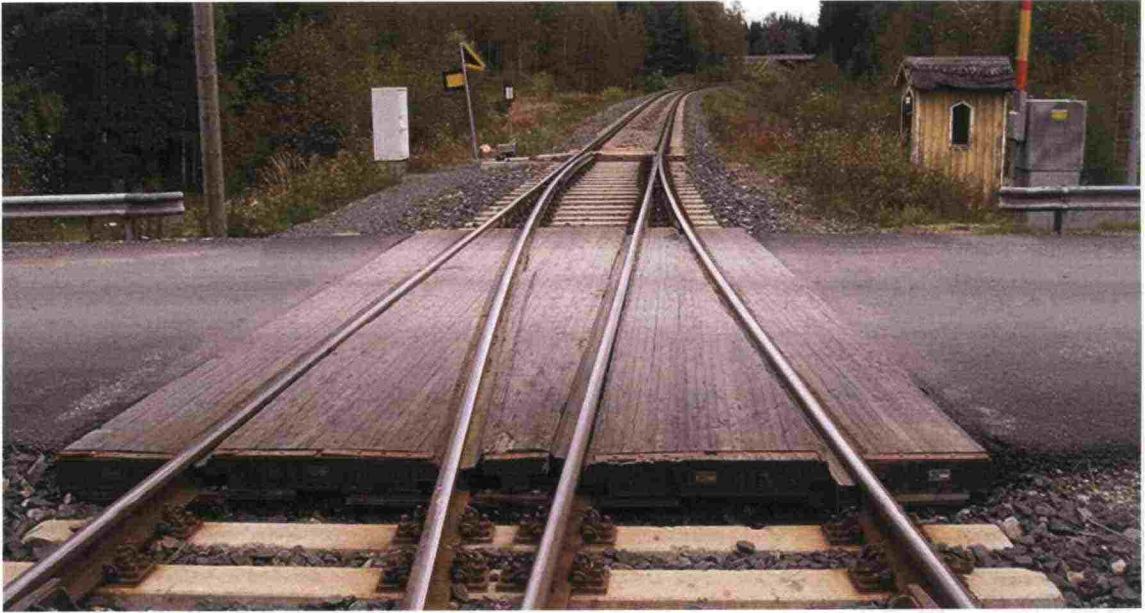
Kuva 61. Puukansirakenne vaihteen sisällä.
