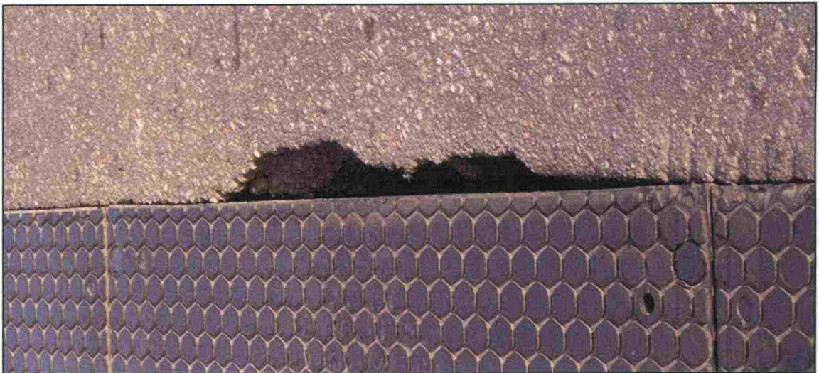
Kuva 36. Normaalivahvuinen asfaltti lohkeaa kumia vasten.
