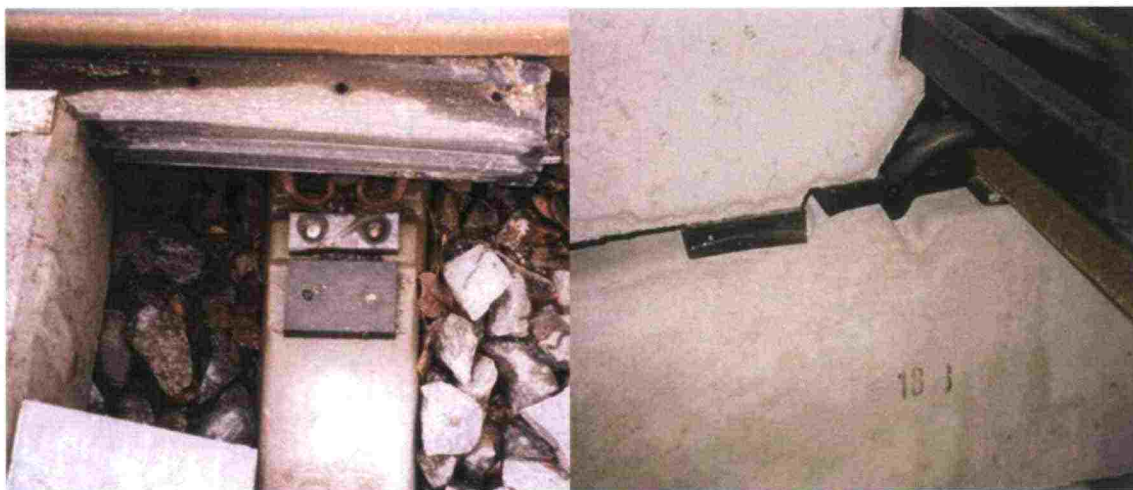
Kuva 50. Ensimmäisen betonitasoristeyskohteen erikoispölkky.
