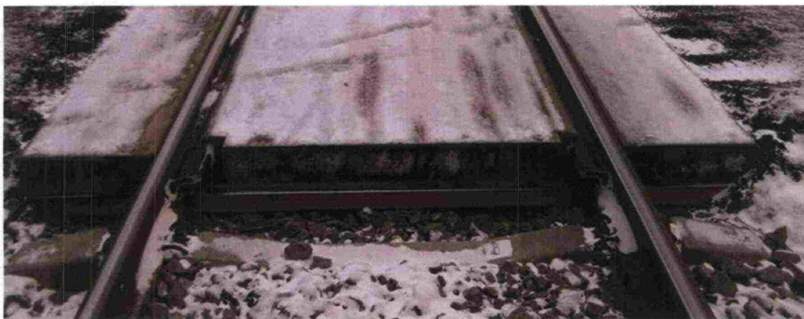
Kuva 29: Läpimenevä ankkurointipuu normaalirakenteessa, jolloin reikäkoossa pitää ottaa huomioon kosteuselämisen pelivarat.
