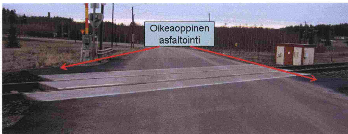
Kuva 55. Elementit porrastettu ja asfaltointi esimerkillinen.
