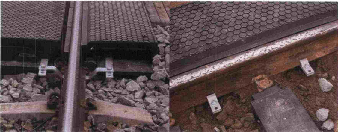
Kuva 67. Moottorikelkkatasoristeyksen lukitus vasemmalla ja reunaelementtien lisälukitus yleensä yhden tai kahden elementin osalta.
