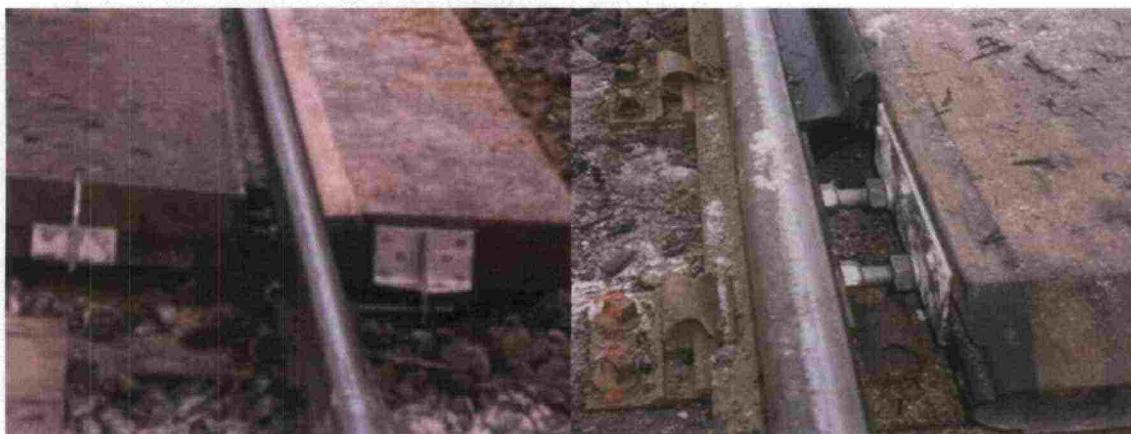
Kuva 26. Kuvan mukaisesta ankkuroinnista luovuttiin ja tilalle kehitettiin kuvan 27 ankkurointitapa.
