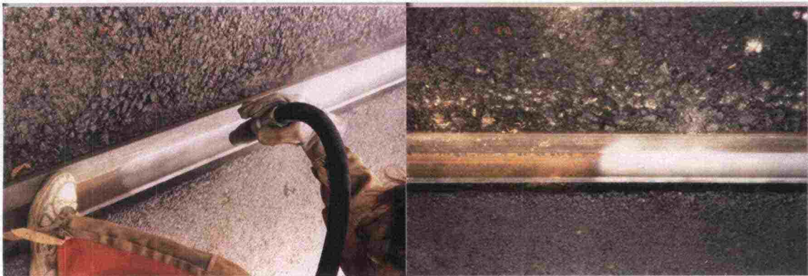
Kuva 76. Urakiskon hiekkapuhallus kuivalla säällä.
