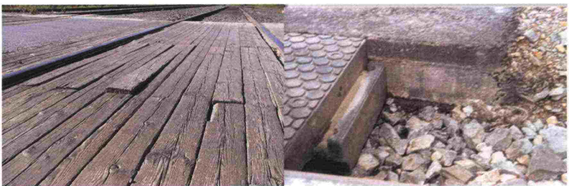
Kuva 6. Keskikansi ei ole enää turvallinen. Kuminen reunaelementtirivi on vaeltanut.
