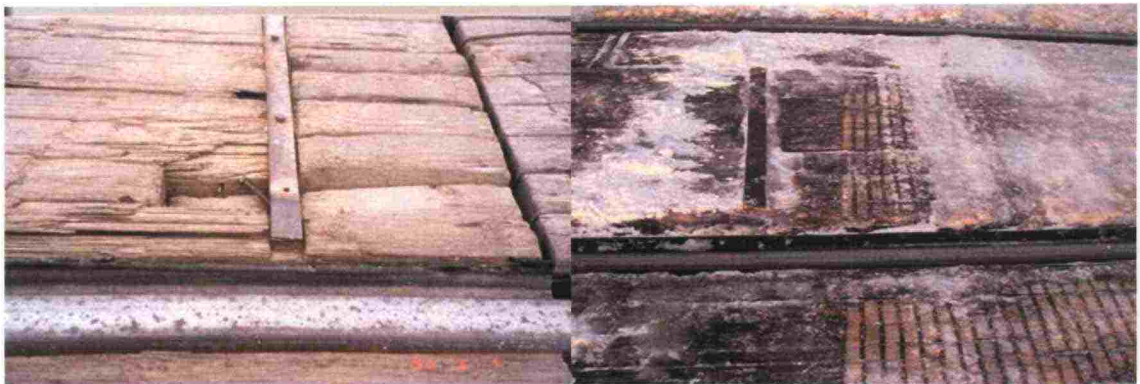
Kuva 1. Sideraudat poikki ja ruuvit osittain irti vasemmalla ja auran terät ovat olleet nostamatta oikealla.
