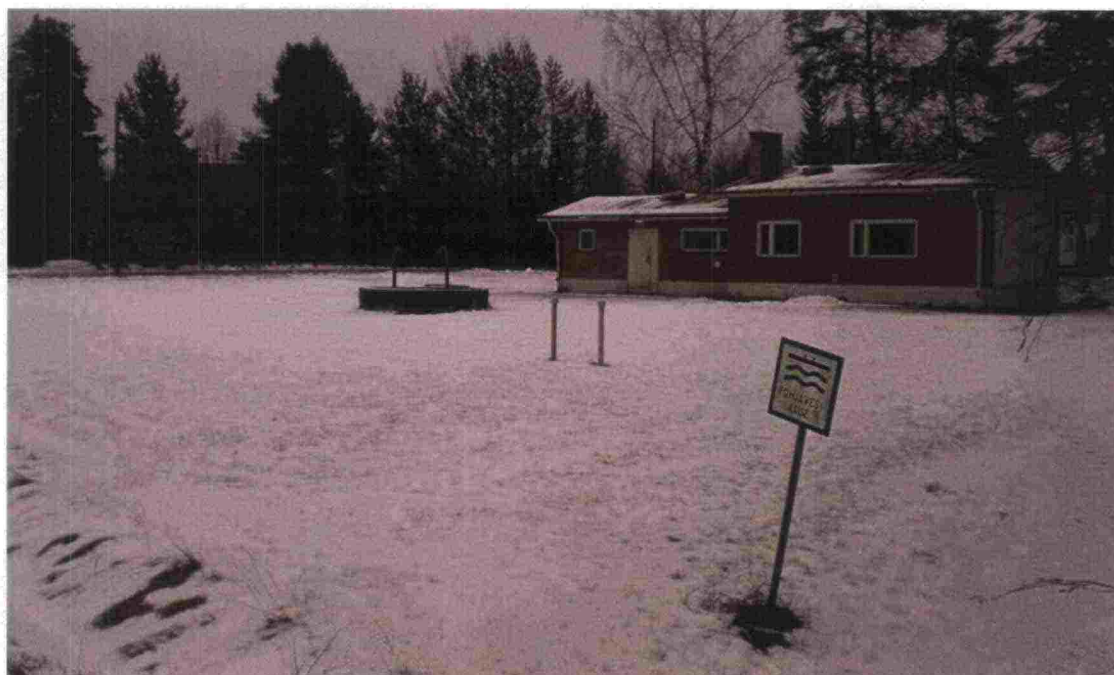
Kuva 1. Keltakankaan vedenottamo sijaitsee noin 100 metrin päässä ratalinjasta.
