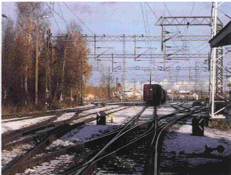
Kuva 5.25 Joensuun tavararatapihan raiteistoja.
