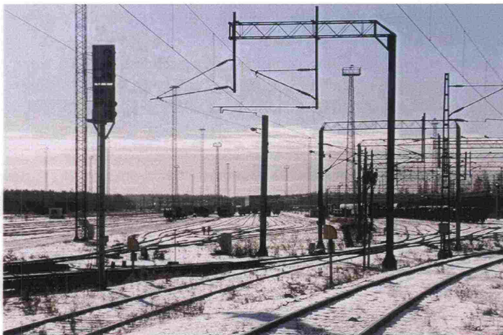
Kuva 5.22 Pieksämäen järjestelyratapihan alaratapihaa.
