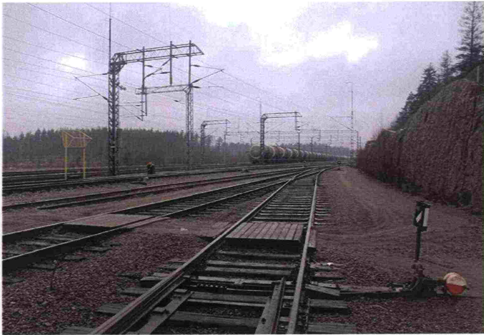
Kuva 5.17 Haminan tulo- ja keskiratapihaa.
