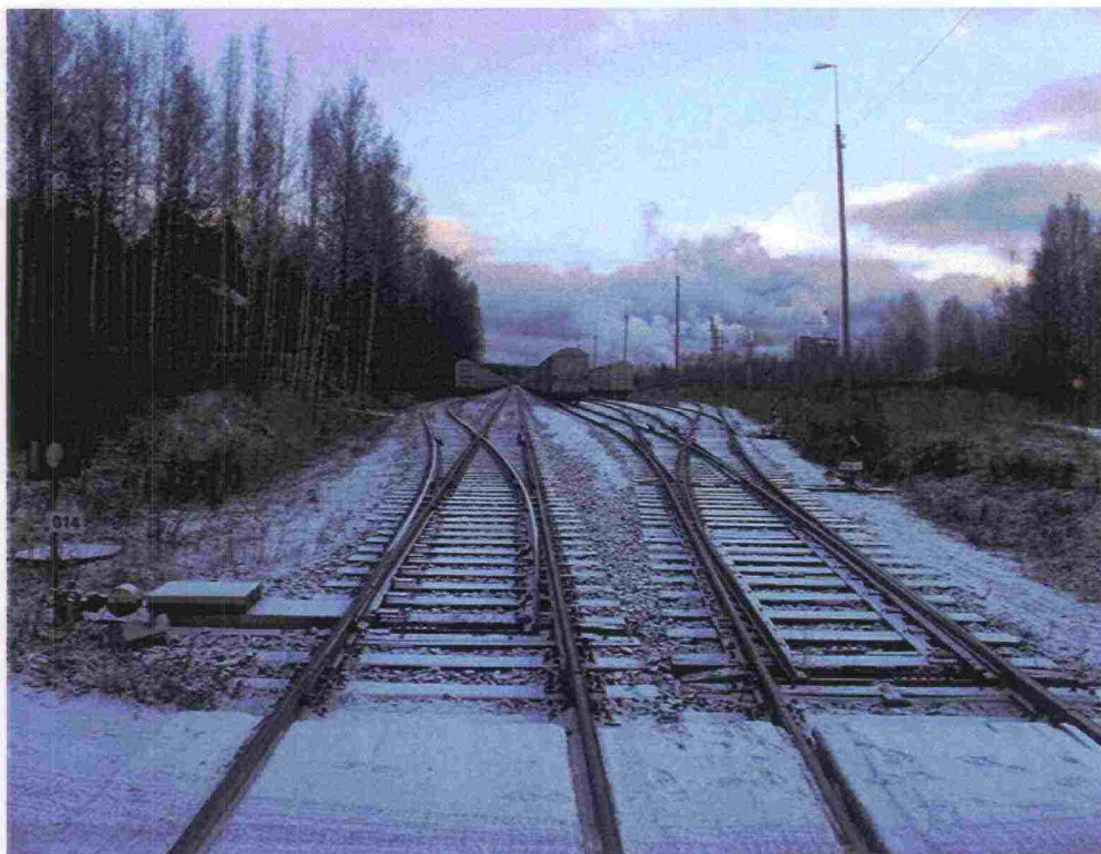
Kuva 5.13 Näkymä Äänekosken ratapihalle pohjoispään tasoristeyksestä.
