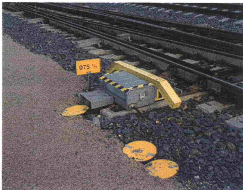
Kuva 6.1. Vaihteenkääntölaite. (Lähde: RHK)
