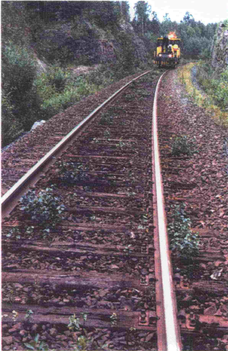
Kuva 5.1. Heikkokuntoista puupölkkytystä. Pölkkyistä kasvaa koivuntaimia, mikä on merkki pölkyn pitkälle edenneestä lahoamisesta.
