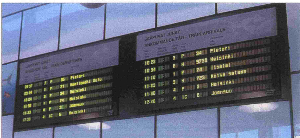
Kuva 35. Esimerkki suuren aseman ajantasaisesta näyttötaulusta asemarakennuksen odotustilassa.
