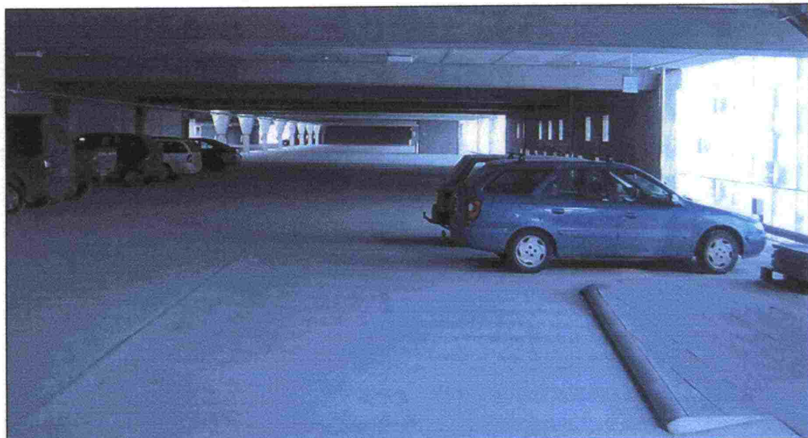
Kuva 51. Pysäköintilaitos on yksi ratkaisu pysäköintiongelmaan varsinkin suurilla asemilla (Jyväskylä).
