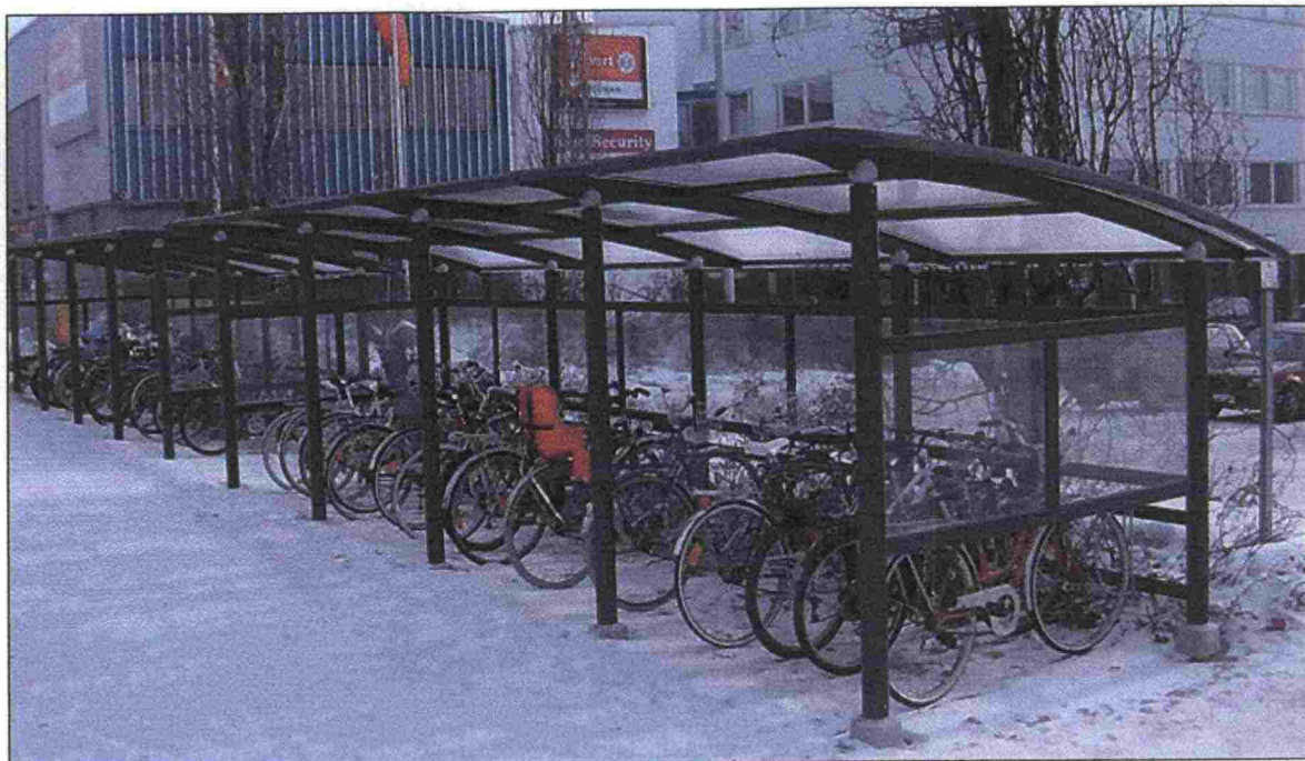
Kuva 52. Usealla asemalla tarvittaisiin uusia, tasokkaita pyöräpysäköintitelineitä (Kouvola).
