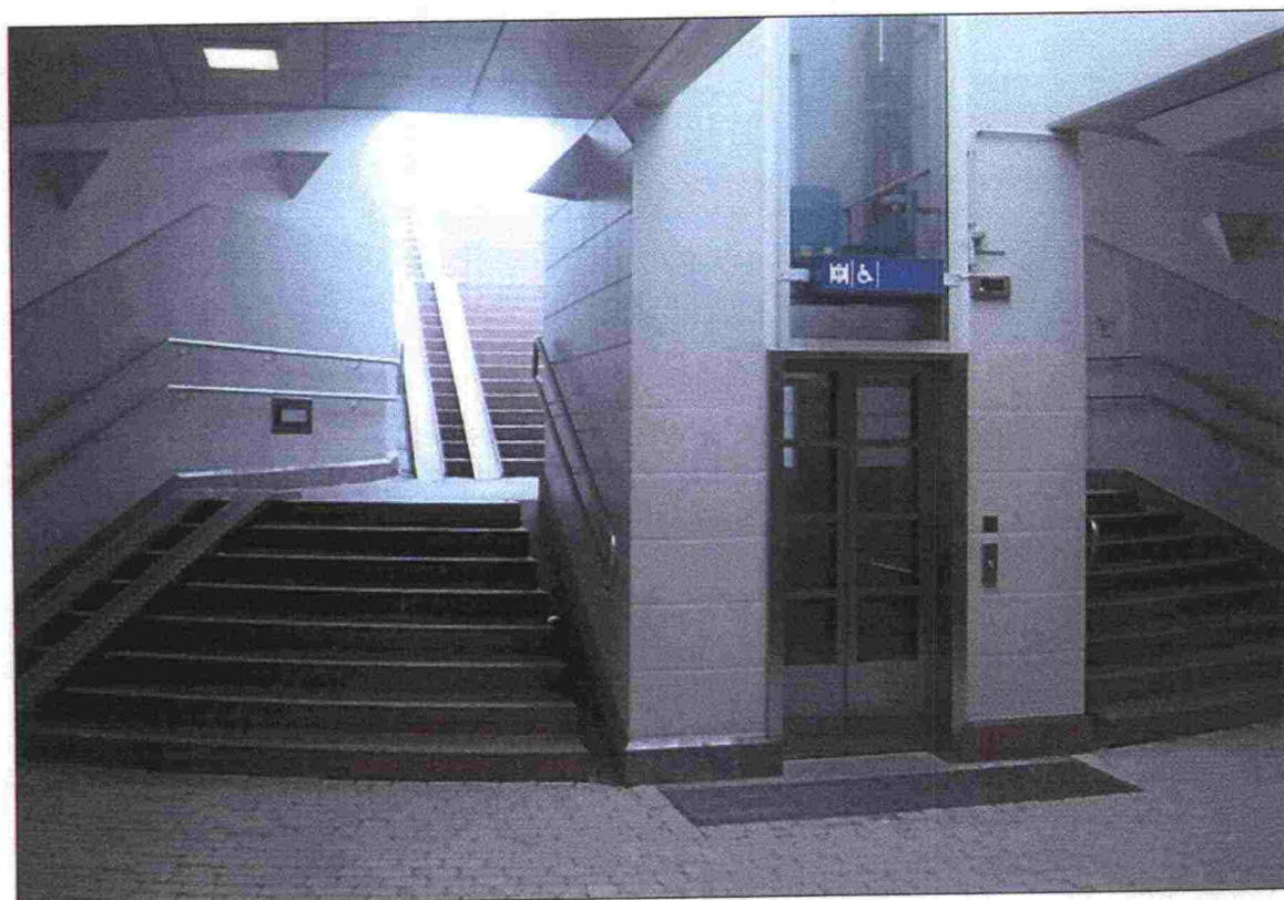
Kuva 59. Asemilla, joilla on monta henkilöliikenteen raidetta, tarvitaan asematunneli, josta tulee olla hissit kaikille laitureille (Hämeenlinna).
