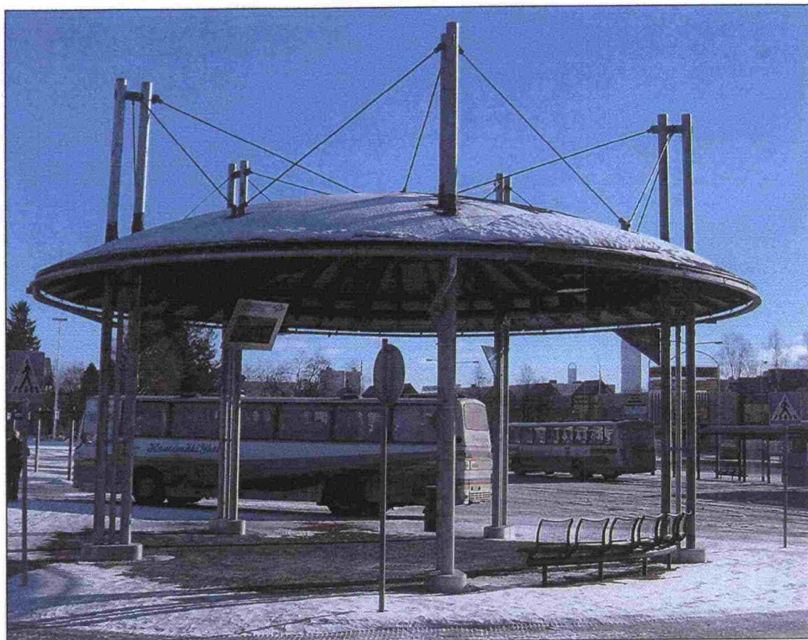
Kuva 53. Rautatieaseman yhteydessä sijaitsevan linja-autoaseman matkustajainformaatiokatos (Seinäjoki).
