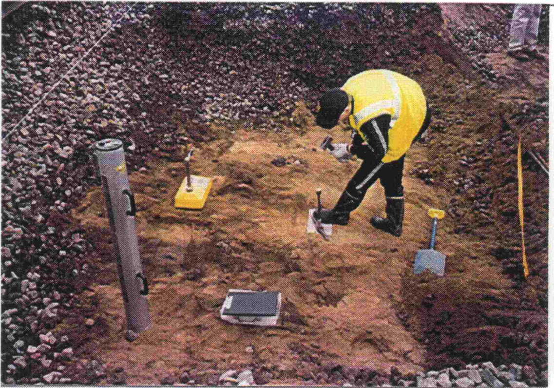
Kuva 2.2:2 Ratapenkereen tiiviuden mittaus aukikaivuun yhteydessä.
