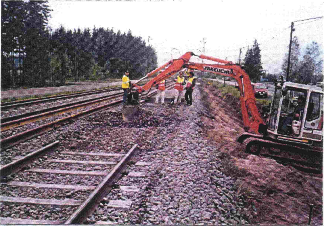
Kuva 2.2:1 Raiteen katkaisu ja ratapenkereen aukikaivuu.
