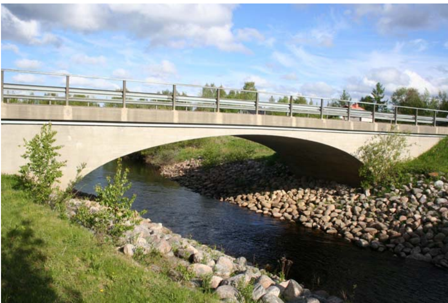
Kuva 10. Vaskurin silta maantiellä 19741 (Siltarekisteri 2008).
