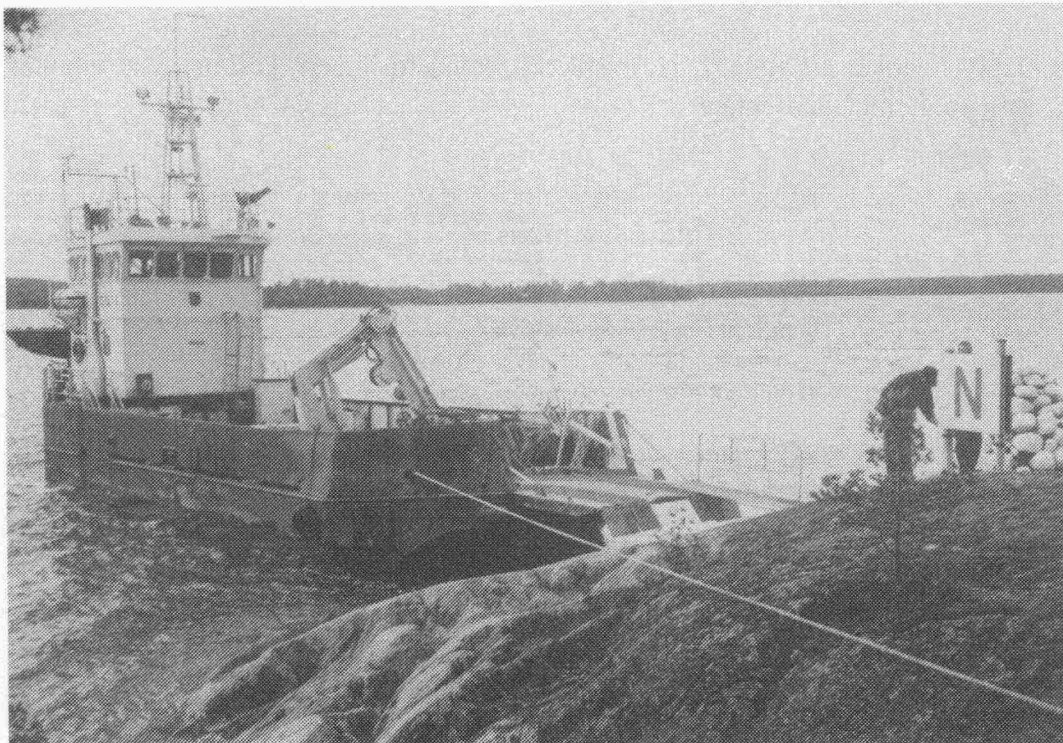
Öljyntorjunta-alus Olli I väylänrakennustöissä.
