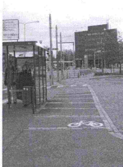
Kuva 4. Esimerkki pyörätien huomioraidoista bussipysäkin kohdalla. Ruoholahti, Helsinki.
