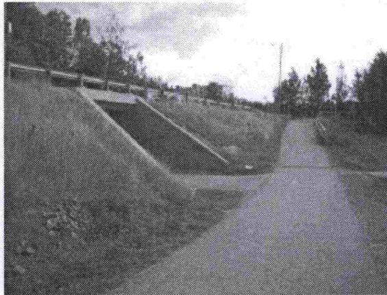
Kuva 3. Alikulkua lähestytään yleensä alamäkeä pitkin. Pääreitillä kulkevien pyöräilijöiden ja rullaluistelijoiden nopeudet ovat huipussaan siinä, missä he kohtaavat alikulusta tulevat ja missä näkemät ovat huonoimmat.
