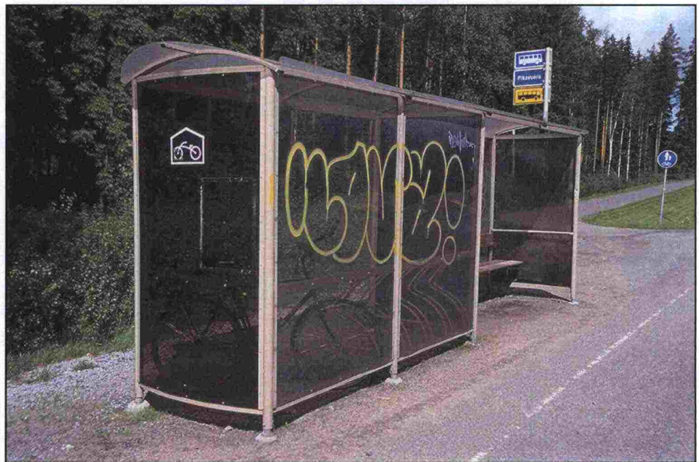
Kuva 9 Tikkakosken pysäkki valtatiellä 4. Pysäkkikatoksessa on tilaa myös liityntäliikenteen polkupyörille. Katoksen kunnossapidon tasossa on vielä parantamisen varaa.
