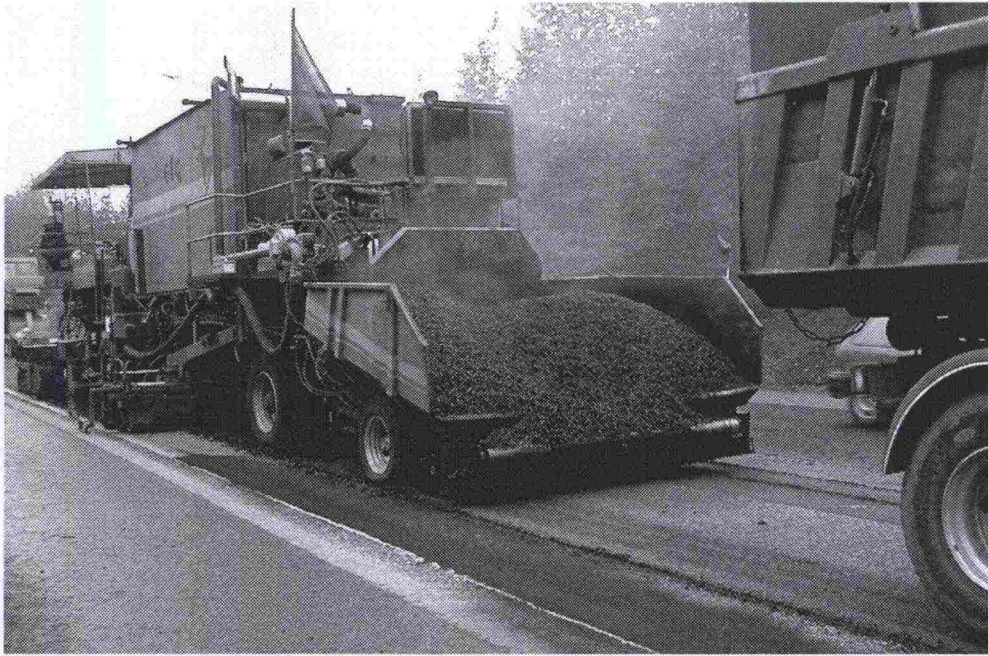
Kuva 3. Lähikuva REM-lisämäärän annostuksesta levittimelle.
