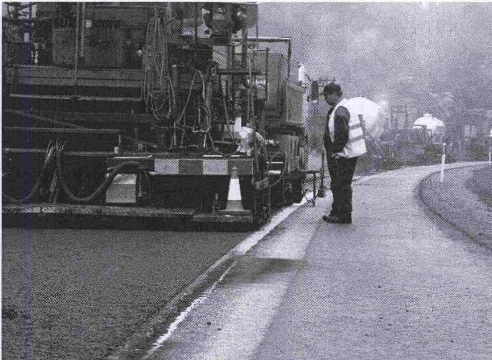
Kuva 4. REM-kalusto menosuuntaan kuvattuna. Valmistettu päällystepinta edessä.
