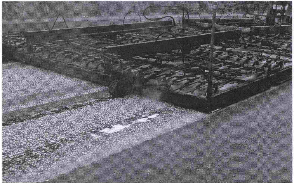
Kuva 2. Lähikuva REM-kuumentimista.
