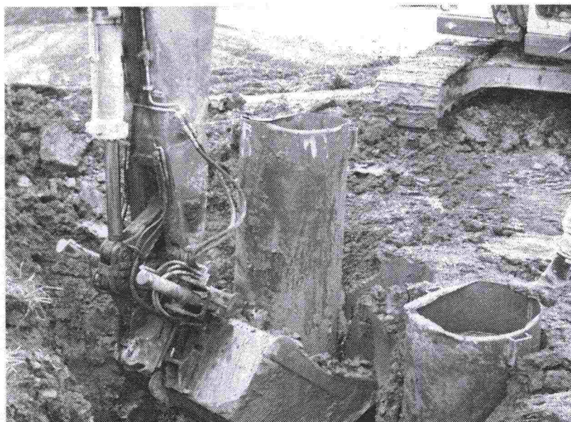
Kuva 42. Koepilarin pätkän irrotus ja nosto maasta.
