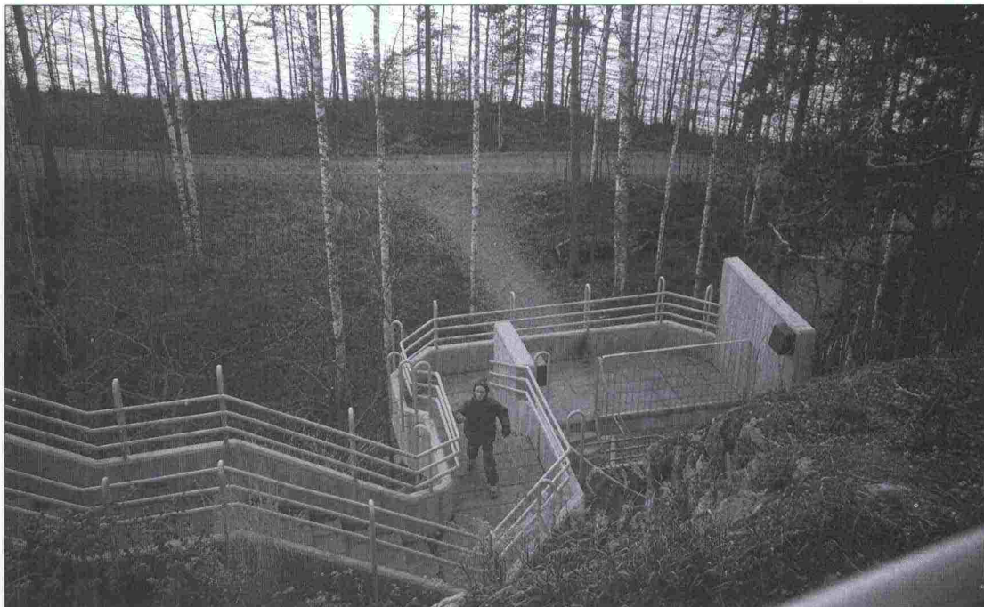
Kuva 55 Rantaan pääsee käyskentelemään veden partaalle.
