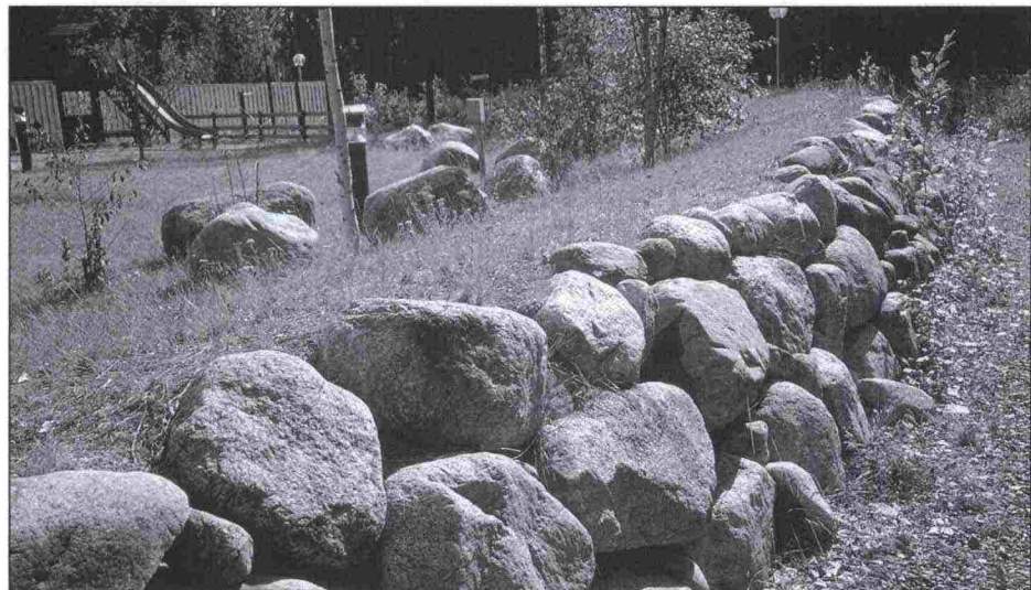
Kuva 93 Tuuliruusun palvelualueella huoltoaseman reviiri rajautuu luonnon ympäristöstä kiviaidan muodostamalla vallilla.
