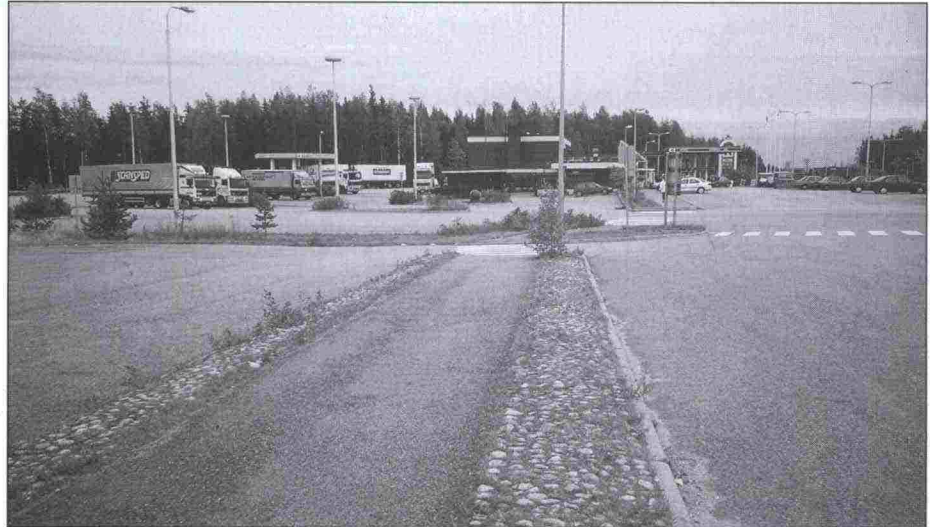
Kuva 56 Levähdysalue sijaitsee liian kaukana palvelurakennuksesta. Levähdysaluetta ollaan purkamassa
