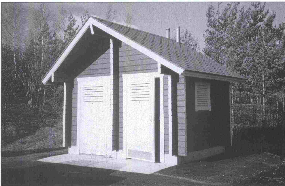
Kuva 21 Taivalkosken tehtaan valmistama puurakenteinen käymälä on valvomattomana ja kylmänäkin kohtalaisen siisti. Hajuhaitat ja ikivalta ovat silti ongelmina
