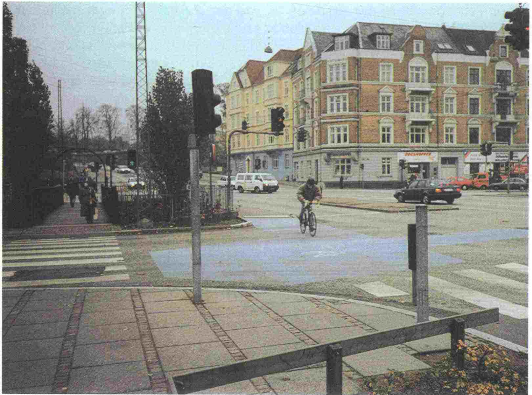
Kuva 23. Sinisellä pyörätien värillä lisätään pyöräilyn turvallisuutta risteyksessä. Århus, Tanska.
