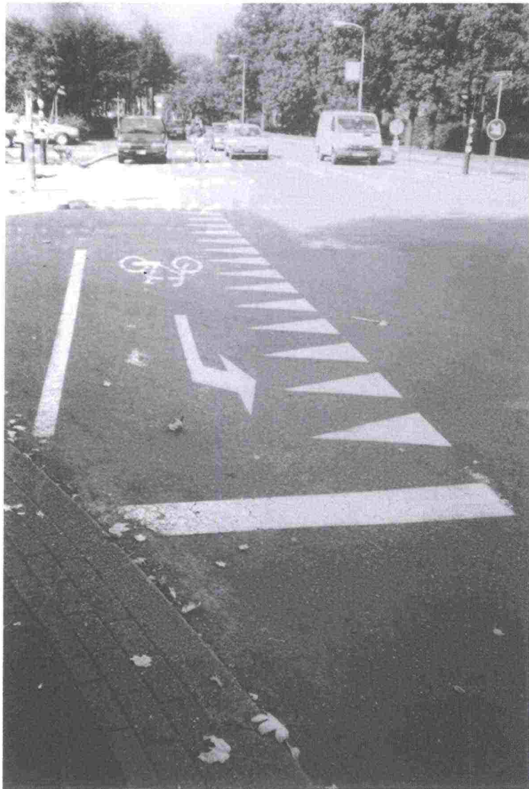
Kuva 26. Kolmioviivalla tehostetaan väistämivelvollisuutta. Delf, Alankomaat.
