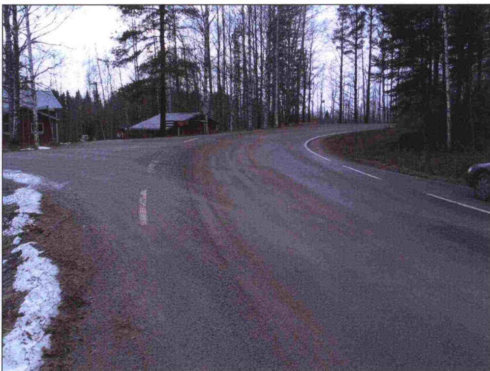
Kuva 4-5. Tölpänlammen kohdalla on jyrkkä mutka. Kuvassa vasemmalla näkyy Salokyläntien liittymä. Mutkan oikaisun yhteydessä alueen liittymäjärjestelyt selkeytyvät nykyisestä.
