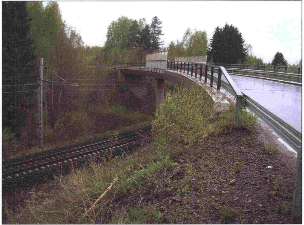
Kuva 4-3. Suhmuran ylikulkusiltaa esitetään levennettäväksi kuvassa näkyvältä eteläpuolelta kevyen liikenteen väylän toteuttamisen yhteydessä.
