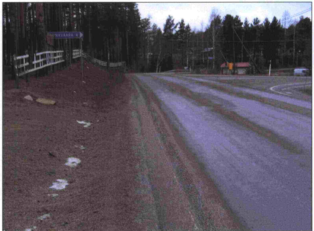
Kuva 4-14. Uuden linja-autopysäkin paikka Suhmuran koulun liittymän länsipuolella, kuvassa heti vasemmalla.
