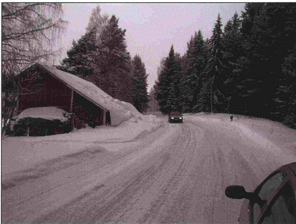
Kuva 3-16. Rakennukset ja pihapuusto sijaitsevat paikoitellen aivan tien reunassa, jolloin tien kunnossapito saattaa aiheuttaa niille vaurioita. Kuvassa katolta valuvat lumet vyöryvät poikkeuksellisesti ajoradalle saakka, Mäntylä.
