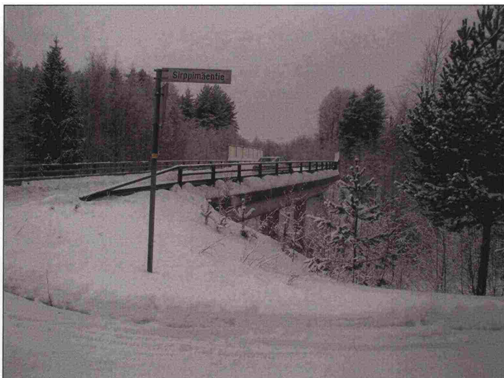
Kuva 3-7. Suhmuran ylikulkusilta idästä kuvattuna. Hankala Sirppimäentien liittymä on kuvassa etualalla.
