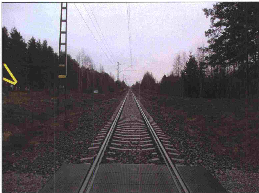
Kuva 2-8. Lapinlahden läpi kulkee Kuopio - Iisalmi rautatie.
