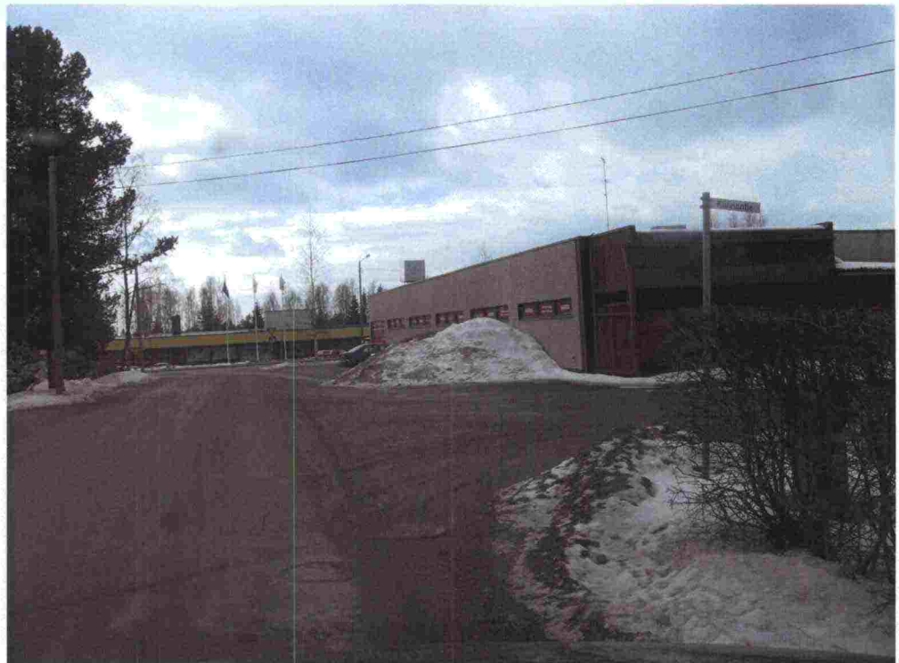
Kuva 19. Kaivotien ja Kunnantien liittymä (kohdenumero 2).
