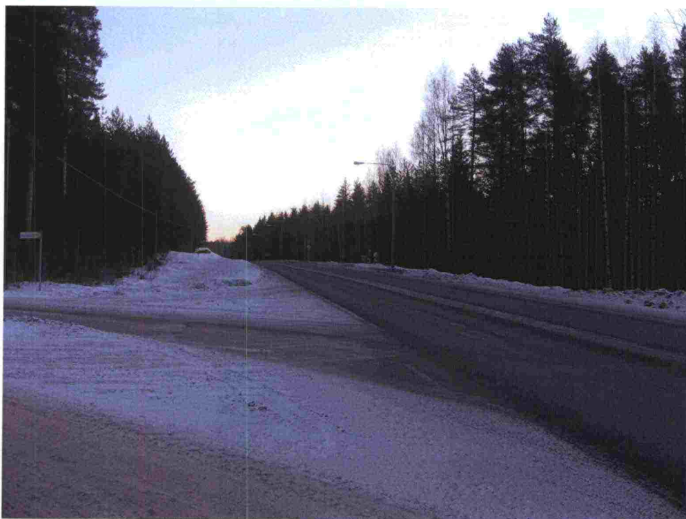
Kuva 4.8. Karhunsalontien ja kantatien 73 liittymän näkemä on puutteellinen Uimaharjun suuntaan.
