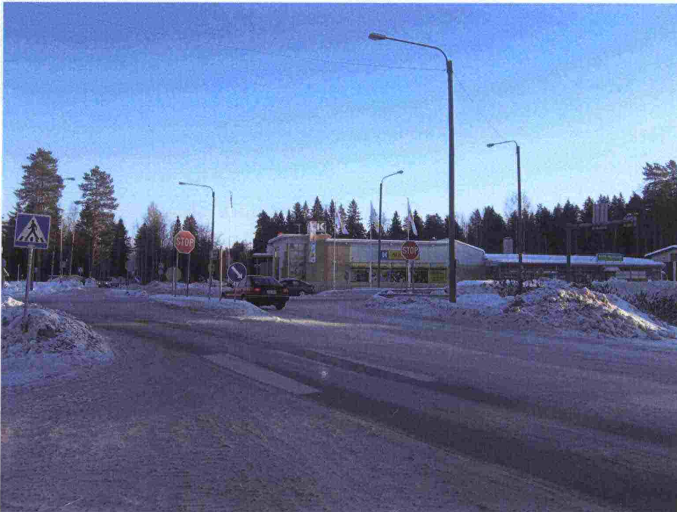
Kuva 4.1. Enontien ja Kauppatien liittymä on Enon taajaman pääliittymä.
