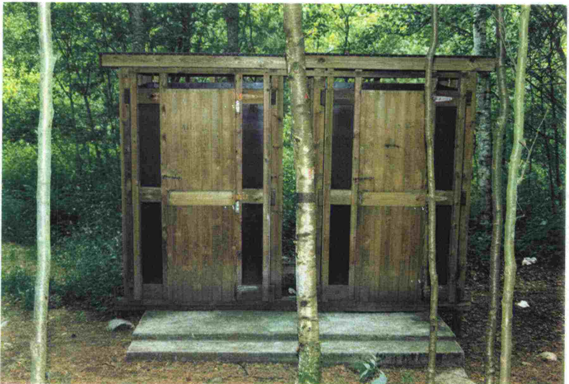
Kuva 13. Tyypillinen levyrakenteinen lietekäymälä. Kuva Mäntyharjun tiemestaripiiristä.
