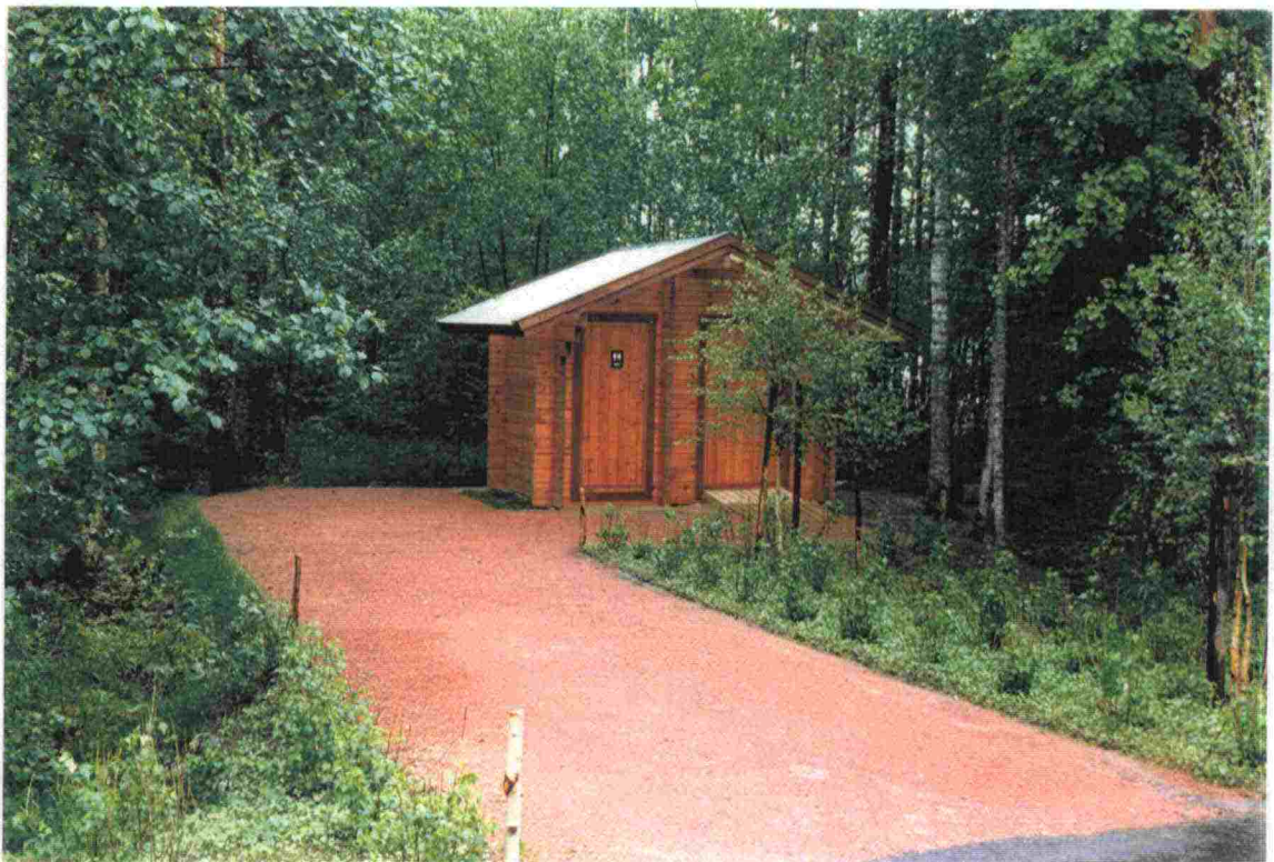
Kuva 10. Hirsirakenteinen lietekäymälä siistimmillään. Kuva Kangasniemen tiemestaripiiristä.
