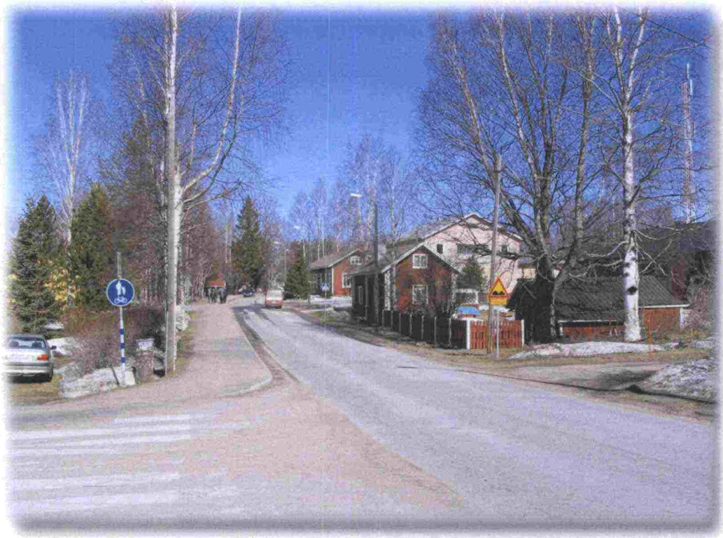
Kuva 1-1 Sumiaistenraitilla korkeita nopeuksia on alennettu töyssyillä.
