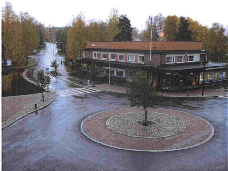
Kuva 5.3-2 Kiertoliittymä on turvallinen liittymämuoto.
