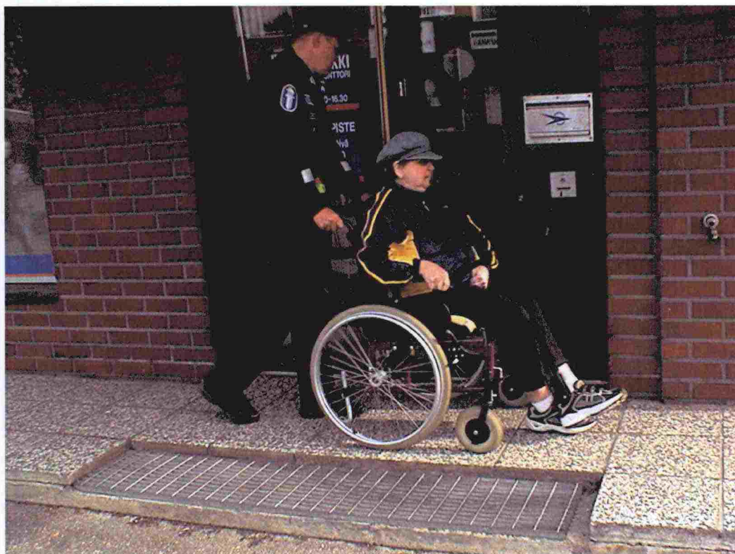
Pyörätuolilla liikkuvan Osuuspankkiin kulkua hankaloittaa korkeella oleva porrastus.
