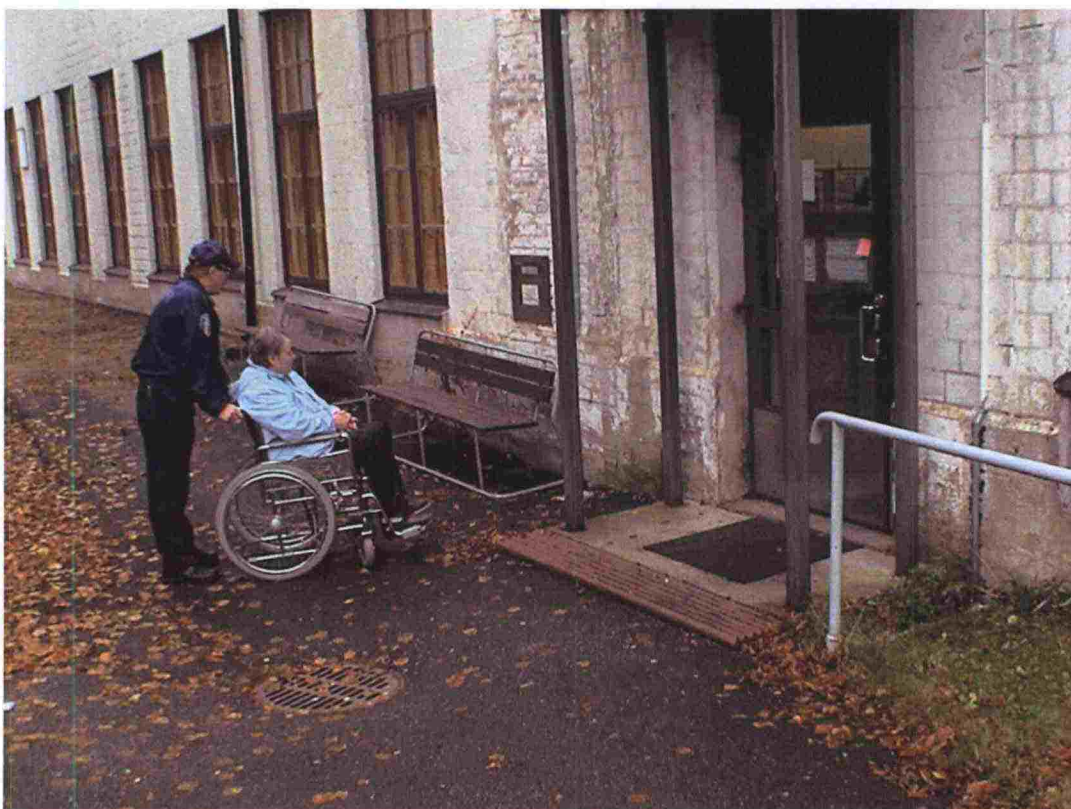
Pyörätuolilla ei pääse kirjaston palautusluukulle.
