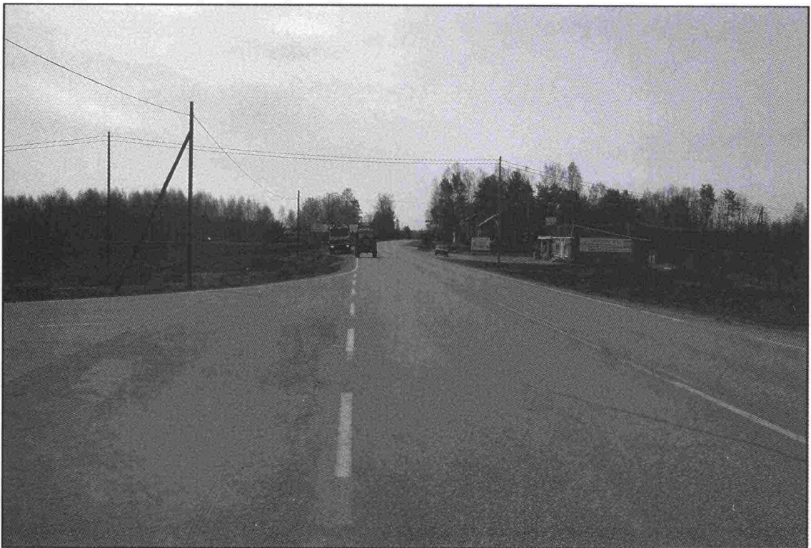
VALOKUVA 2.6-2 Virmutjoen kohta Puumalantiellä
