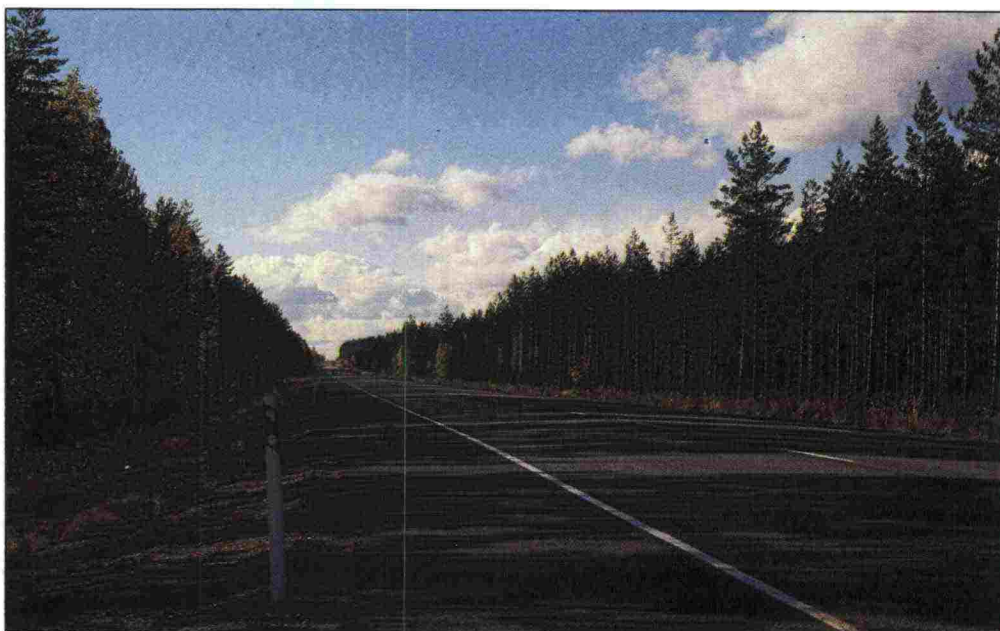
Kuva 55 Suljettuun harjumetsään tehty tie vaatii huolellisen maastonmuotoilun. Kuva valtatieltä 6 (Koskenkylä-Joensuu)
