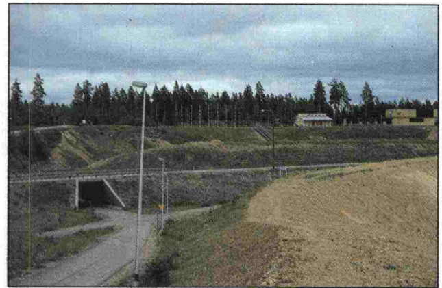
Kuva 65 Mt:n 408 viimeistelemätöntä ympäristöä.
