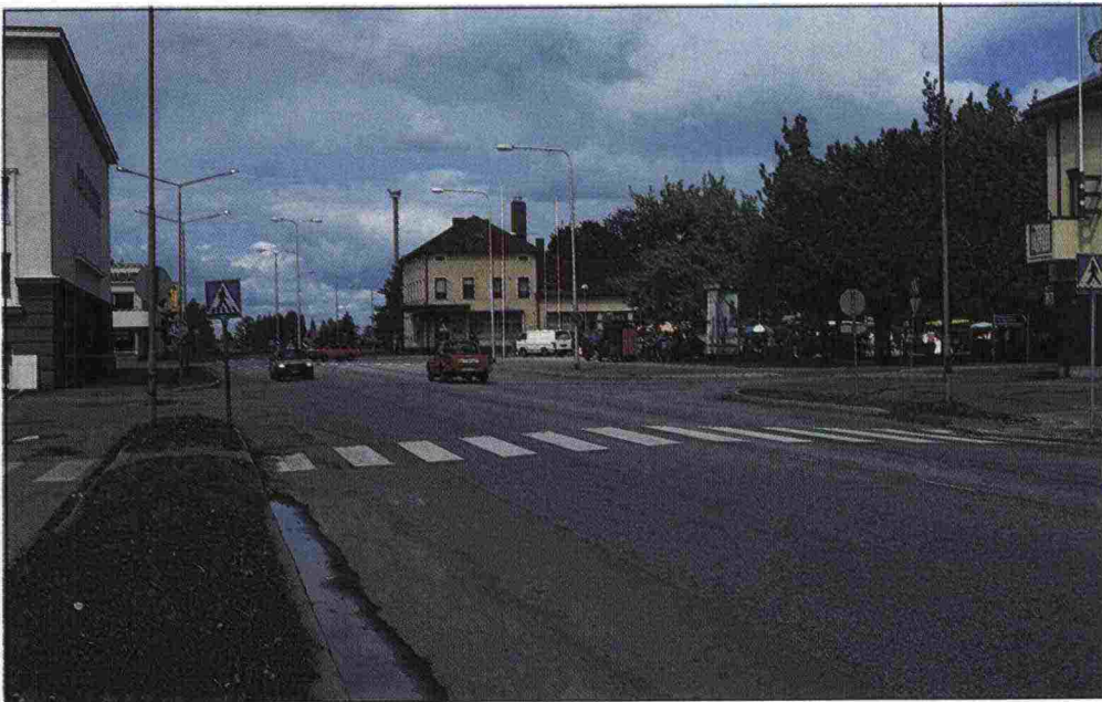
Kuva 24 Myllykosken taajamatiejaksoa. Maantie 3593 on ilmeeltään väljä ja tilallisesti heikosti hahmottuva.
