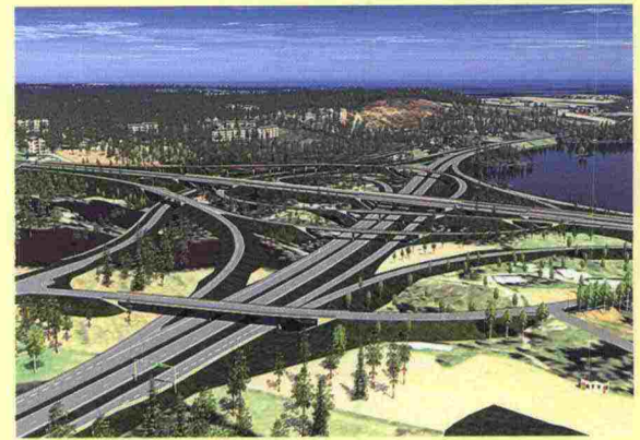
Valtatie 3 Tampereen läntinen kehätie, Pitkänien eritasoliittymä ensimmäisen rakennusvaiheen valmistuttua.
