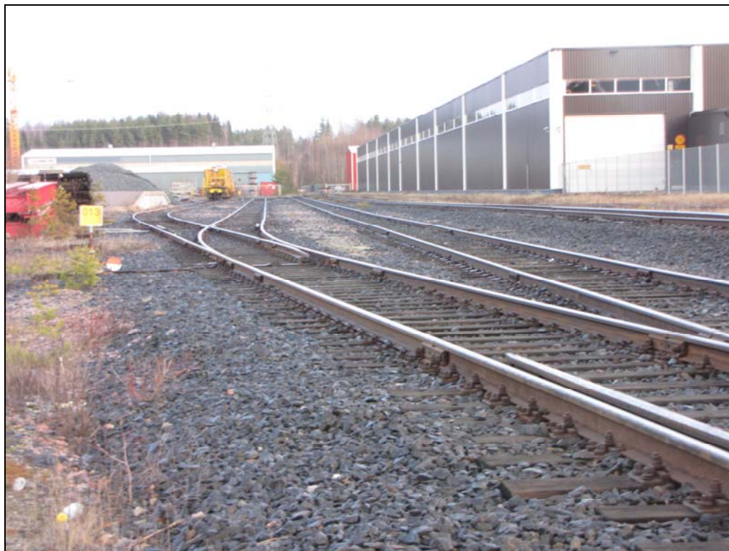
Kuva 20. Hakkilan sepelinlastaus- ja varastoalue.
