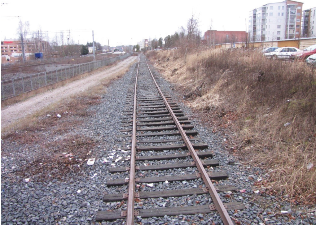
Kuva 25. Järvenpään raide (714) ja tieyhteys sille.
