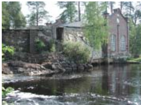
Saarion voimalaitoksen turbiinihalli (oik.)
