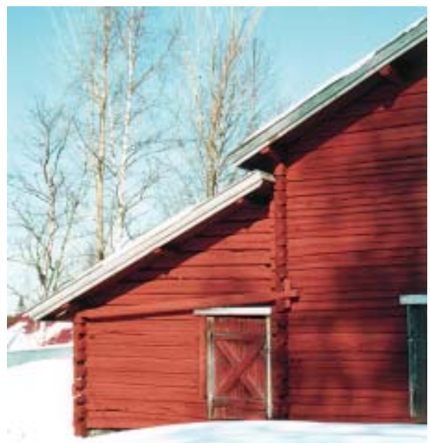
Lahnalammen riihi. Neuvokas tukirakenne liittää korsun tukevasti riiheen.
