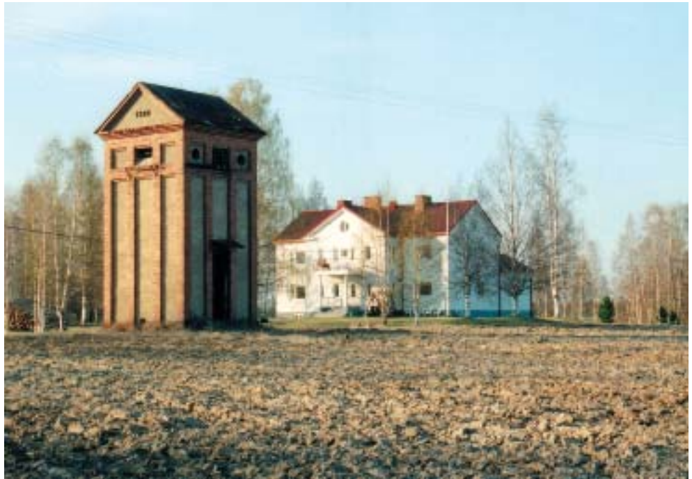
Valkeatalo ja muuntamo
