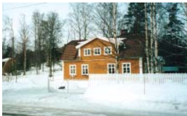
Tikkanen asema. Korkea aita peittää komean asemarakennuksen ja tukkii kyläaukean näkymän.
