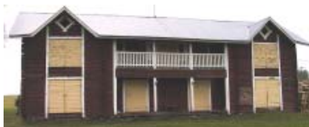
Korholan aitan on rakentanut tietävästi venäläinen rataurakoitsija ja sen rakentamiseen on käytetty vanhoja hirsiiä.
