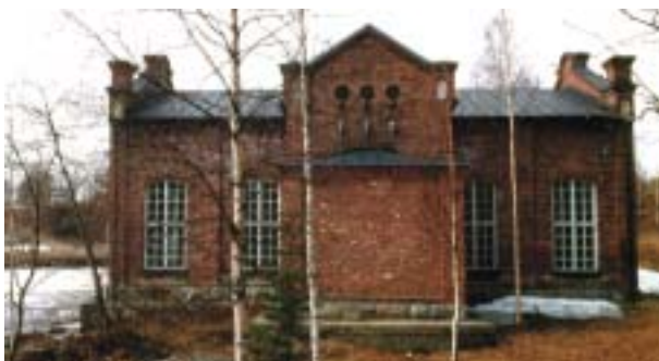
Saarion voimalaitoksessa toimii voimalaitosmuseo.
