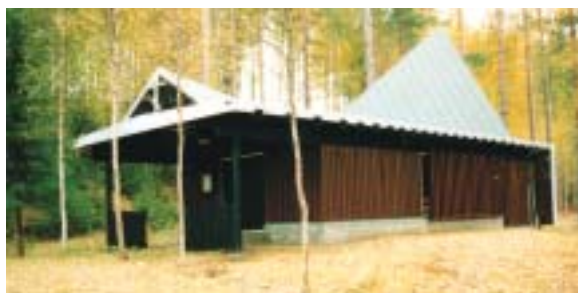
Petravaaran tsasouna onkin erikoinen moderni rakennus (arkkitehti Vilho Suonmaa 1964).
