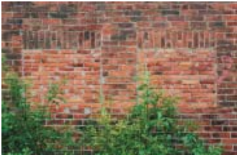
Teollisuusrakennuksen umpeenmuurattuja ikkuna-aukkoja
