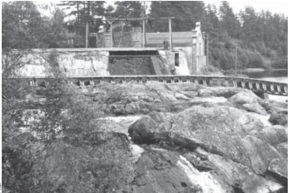
Saarion koski 1962 ennen uuden voimalaitoksen rakentamista
