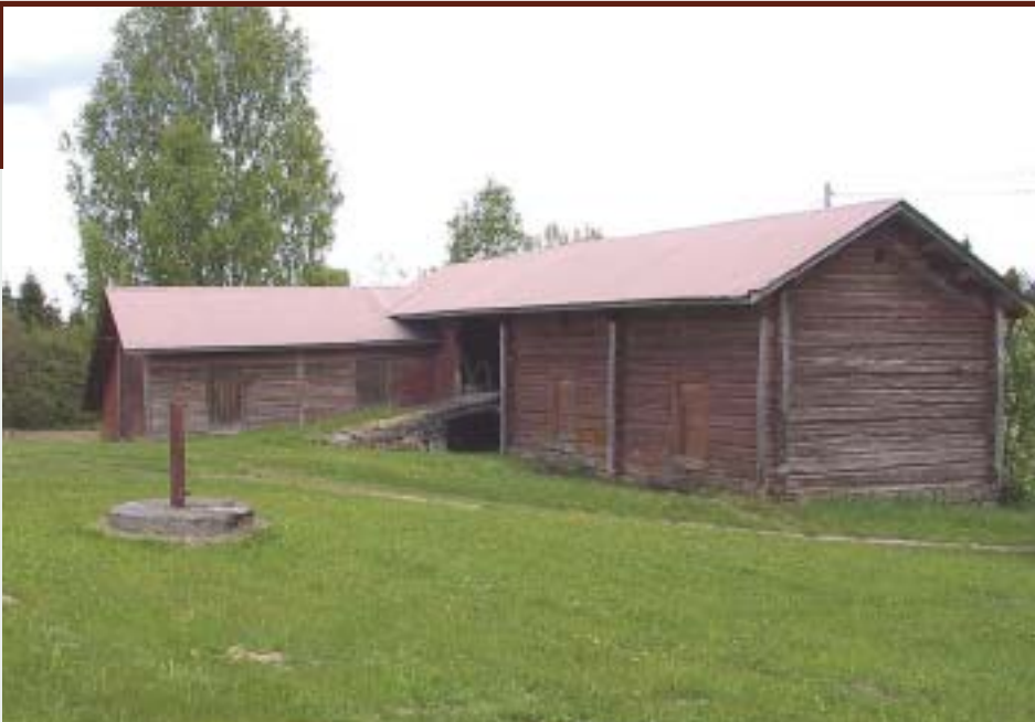
Suuri kulmamuotoon rakennettu talousrakennusten yhdistelmä Kankivaarassa.
