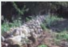
Vanhaa kiviäitaa kunnostetaan Heraniemellä.
