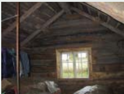
Ullakoilla on rakennetekniikka säilynyt usein pelkistetyimmillään.
