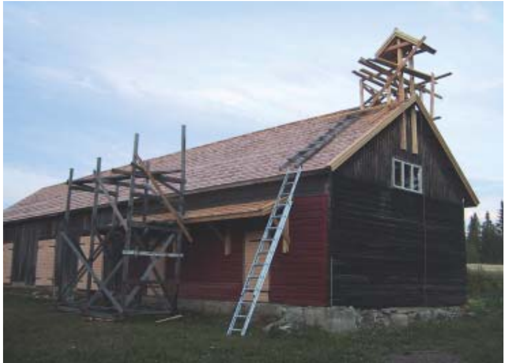
Katajamäen piharakennuksen kattoa muutetaan pärekatoksi kesällä 2003.
