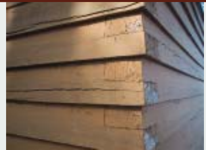
Erikoinen hirsirakenne Oksalan huvilasta Hirvirannassa.
