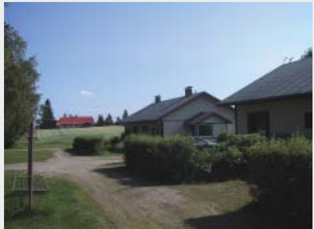
Maaseudun toiveikkuuden aikaa: rivitaloja rakennettiin syrjäisiinkin kyliin 1970- ja 80-luvuilla. Romppalan talot sopeutuvat varsin hyvin kylän maisemaan koulun naapurissa.
