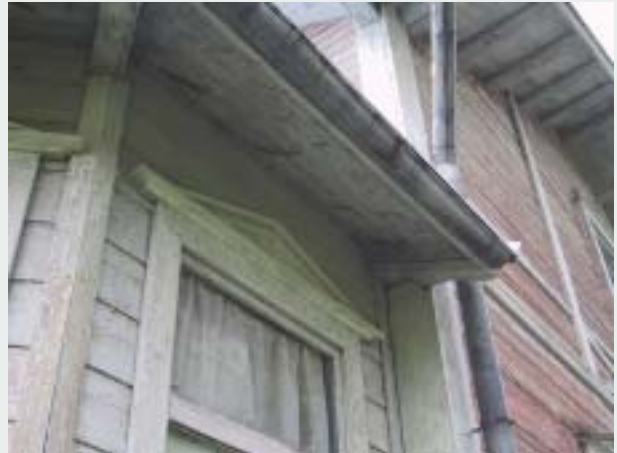
Räystäiden, nurkkien ja ikkunoiden yksityiskohtia Paiholan Mäkelästä.
