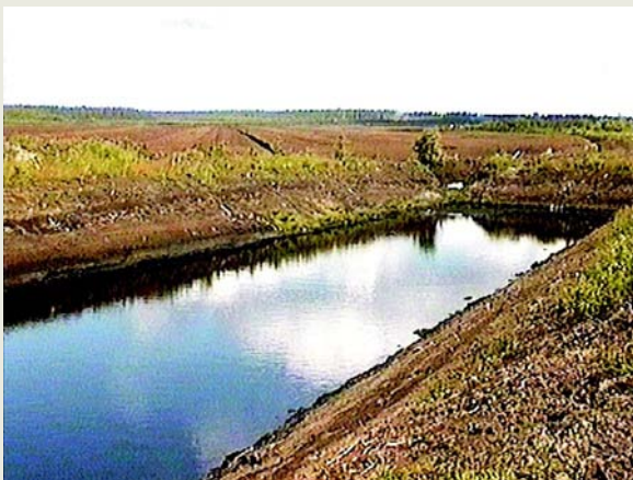
Turvetuotannon vesistökuormitusta voidaan pienentää laskeutusaltailla.
