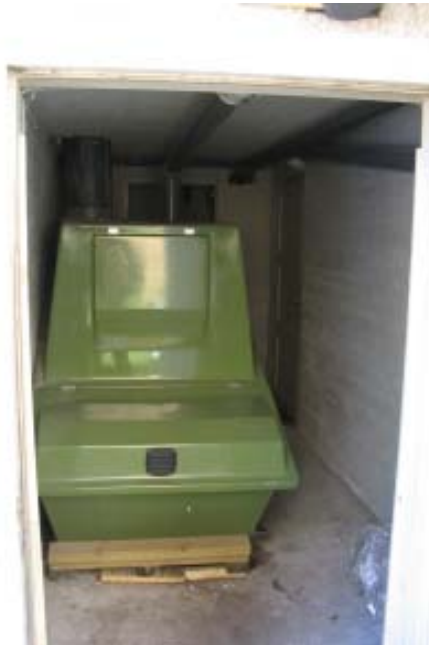
Kuva 16. Multrum käymälä Koetalous Strandbo-lugnetissa
