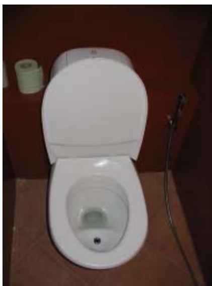
Bild 17. Gustavsberg. Urinseparerande vattenklosett
