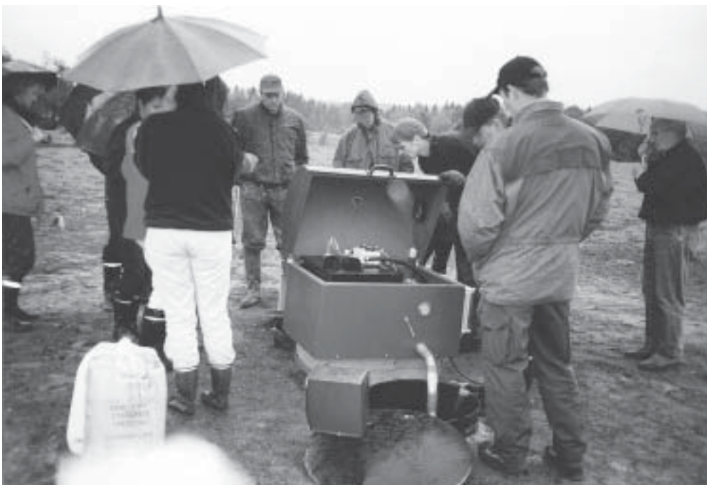
Kuva 10. Maito huoneiden mallikohteita rakennettiin Life-projektin aikana 12 tilalle. Kuvassa rakennetaan panospuhdistamo.
