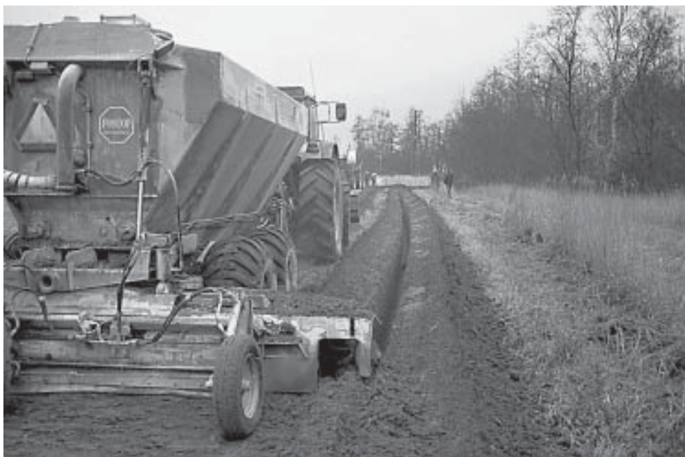
Kuva 4. Kalkkisuodinojitus kiinnosti vain muutamia Lappajärven alueen viljelijöitä. Kuvassa kalkkisuodinojaa rakennetaan Kurejoen varseen.
