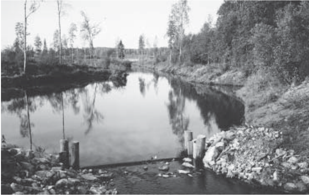
Kuva 13. Lappajärvi Life – hankkeessa rakennettiin Tarvolaan laaja kosteikko, joka vähentää sekä metsäojituksen että peltoviljelyn aiheuttamaa vesistökuormitusta.
