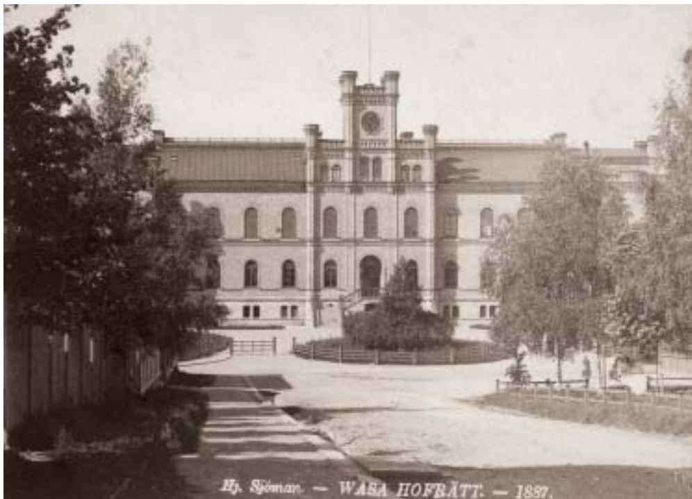
Kuva 2. Hjalmar Sjömanin 1887 ottama kuva Hovioikeuden edustalta. Puistikoiden ja puistojen istu- tukset ympäröitiin 1800-luvun jälkipuoliskolla matalilla kaksi- tai kolmiorsisilla aidoilla, jotka poistet- tiin valtuuston päätöksellä 1902. Talon edustalla pyöreän nurmikoon keskellä kasvoi kuvan ottoaikana pensaiden ympäröimä matalahko lehtipuu - Kuva PM.
