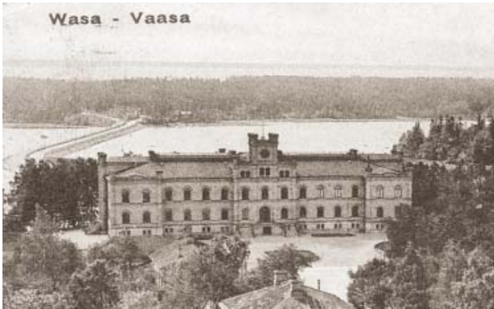
Kuva 6. Hovioikeuden edustalla Rantakadun varressa olevien kolmen kiviterassin rakentaminen lienee pantu alulle jo 1910-luvun alussa. Kirkontornista otetusta kuvasta tehdyssä postikortissa erottuvat osittain puiden peitossa olevien keskeneräisten terassien kivireunukset. Kortti on postitettu vuonna 1914. Terassit täytettiin 1917 Klemmettilän ratapihatyömaalta tuodulla mullalla. - PM.
