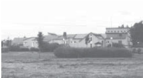
Kuva 79. Päiväkoti Kissankello, kaupunginarkkitehti Helena Teräväinen.
