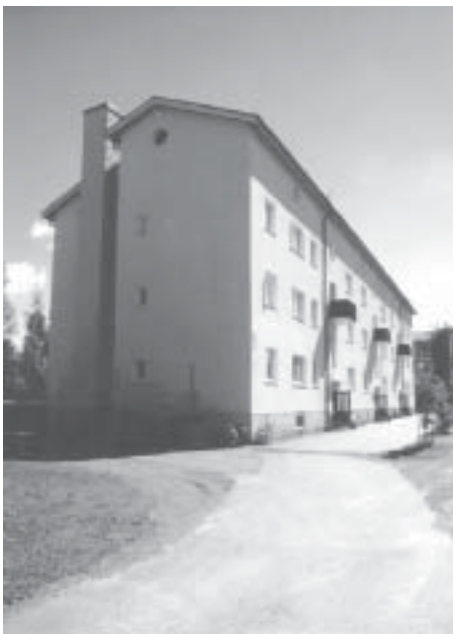
Kuva 40. Jälleenrakennusajan kerrostaloarkkitehtuuria Kokkolassa, arkkitehti Hilding Ekelund, 1945.
