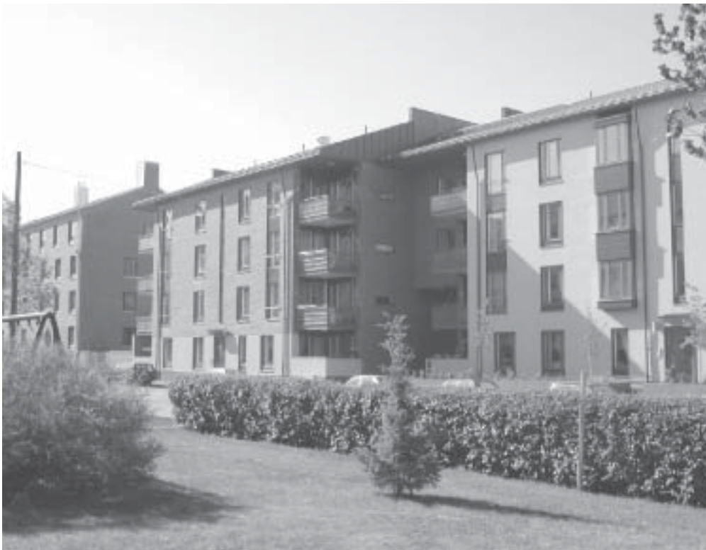
Kuva 86. Uutta rakentamista Koulukadulla.
