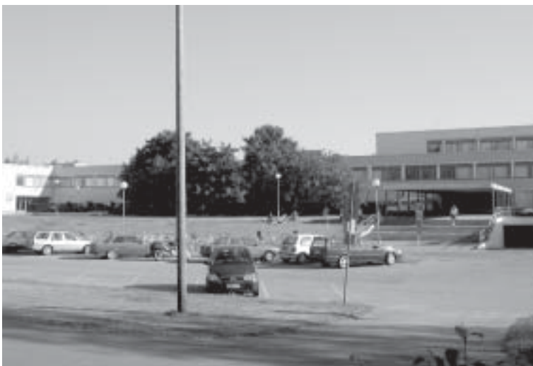
Kuva 58. Vaasan entinen kauppaoppilaitos valmistui vuonna 1974.
