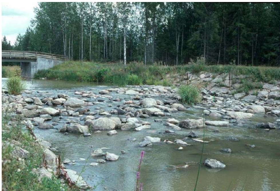
Kuva 1. Taasianjokeen tehtiin vuosina 1990–1997 useita koskimaisia pohjakynnyksiä. Kuva: Pasi Lempinen.
