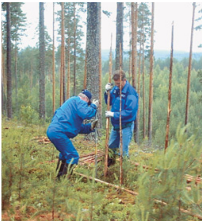
(Ylh.) Suonenjoen Lintharjun ulkoilureitille tehtiin lumiesteeksi pisteaitaa. (Vas.) Taisto Huovinen opetti pisteaidan tekemistä Lintharjulla. Valok. Esko Karvinen.
