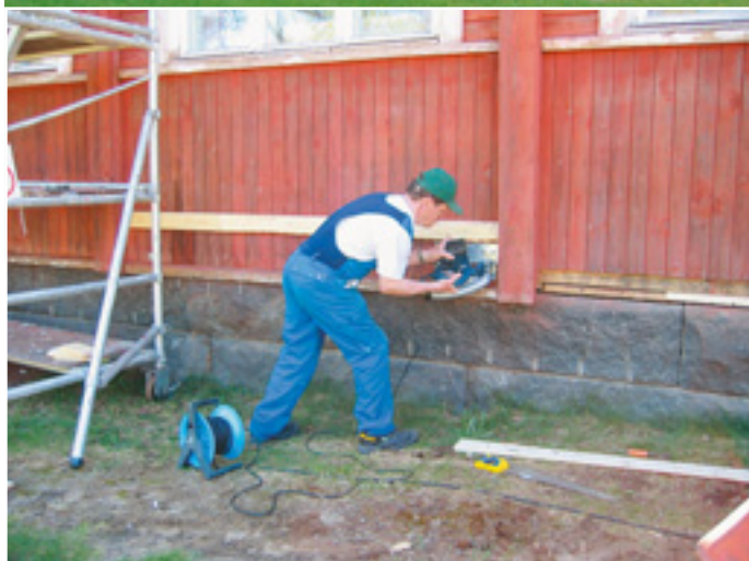
(Ylimpänä) Kunnostettu Työväentalo on saanut uuden ilmeen. (Vas.) Ulkovuorauksen lahot alaosat poistettiin ja tilalle laitettiin vaakalaudat. (Oik.) Työväen talon pihapiirissä olevan ulkorakennuksen vuoraus uusittiin ja rakennus maalattiin.
