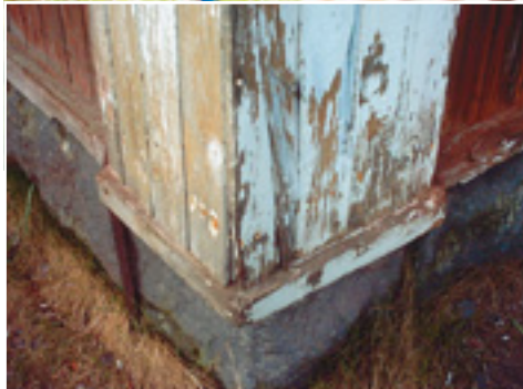
(Ylh.) Rautalammin työväentalon julkisivut kunnostettiin. Valok. Esko Karvinen. (Vas.) Nurkkalaudat ennen kunnostusta. Valok. Esko Karvinen. (Oik.) Ja kunnostuksen jälkeen. Valok. Esko Karvinen.
