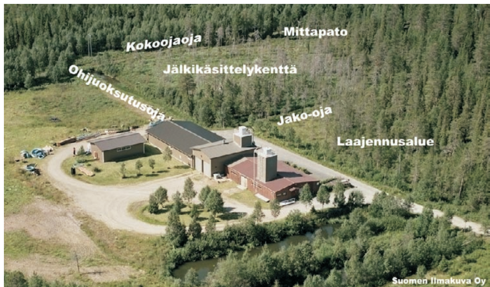
Kuva 1. Rukan puhdistamo, jälkikäsitteilykenttä ja suunniteltu laajennusalue.
