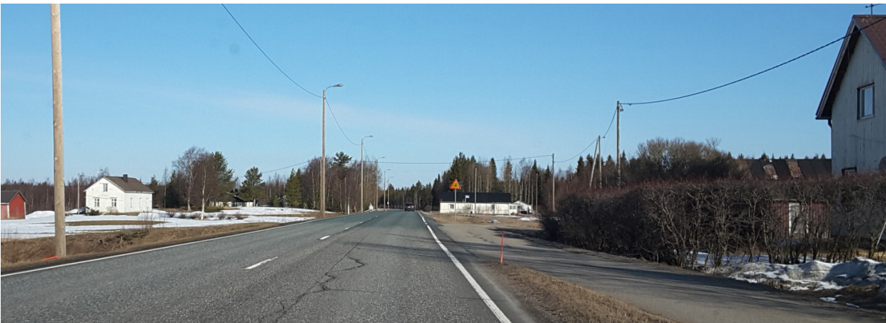
Kuva 13. Osuus valtatieltä, jossa ajoradan sekä jalankulku- ja pyöräilyväylän välissä on vain reunaviiva.
