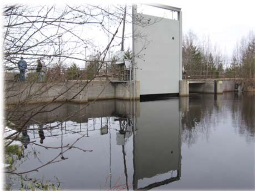
Kuva 7. Hattarin voimalaitoksen tasoluukku 4.4.2007. Kuva Pekka Leiviskä.
